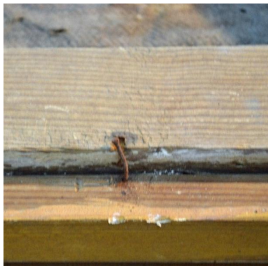
022_0115_bastidor_marc.jpg Imatge de la fixació del marc al bastidor.
