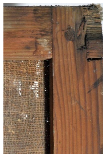
027_0115_bastidor3.jpg Unió del travesser al bastidor.
