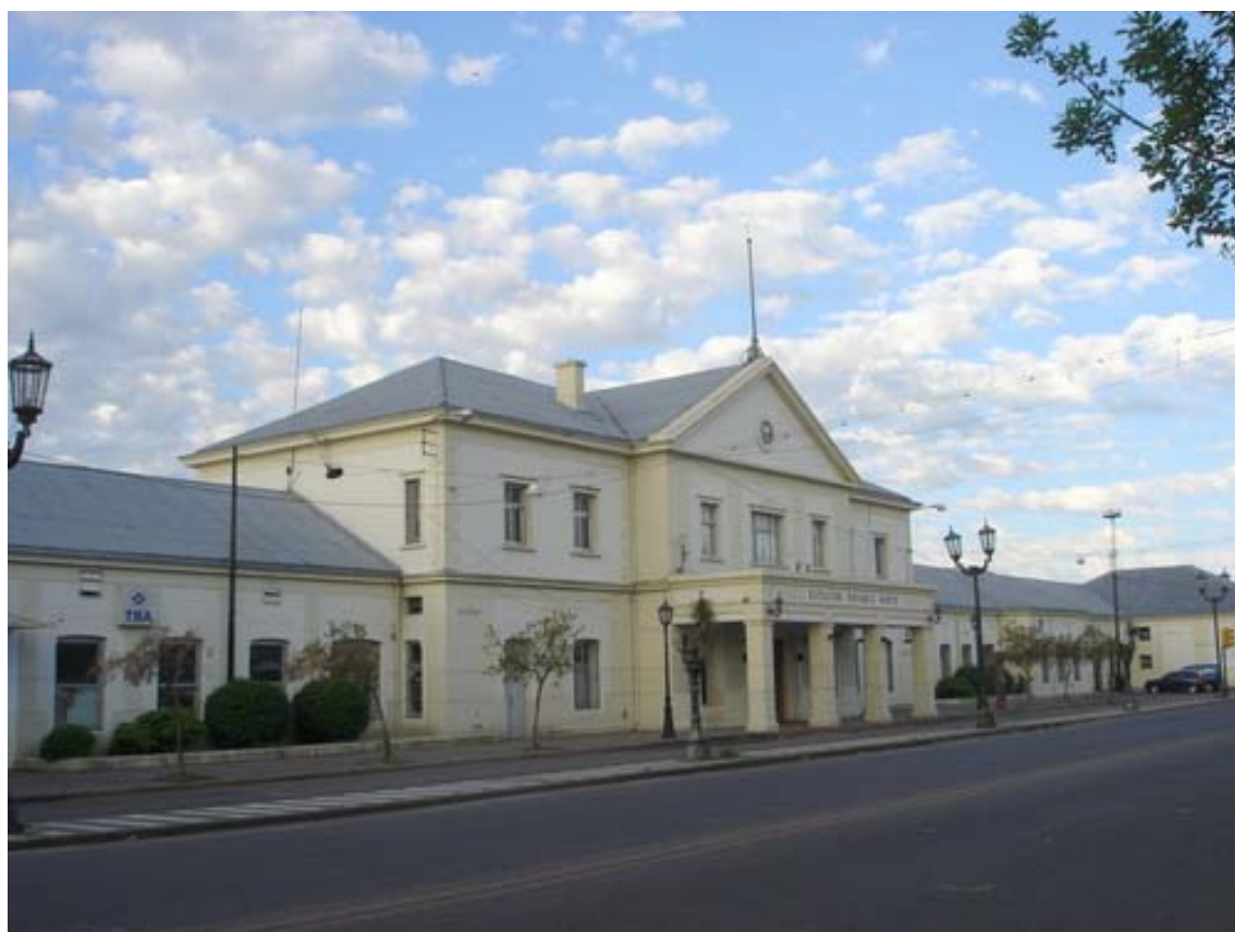
Façana del Museu de la Memòria de Rosario (Estació Rosario Nord)
