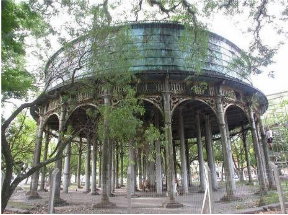
Figura 77: A caixa d'água de ferro, Fonte: Acervo do Serviço Autônomo de Saneamento de Pelotas - SANEP - 2004
