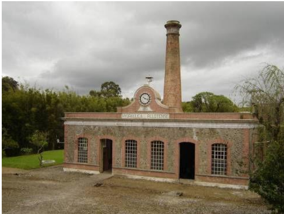
Figura 91: Casa de máquinas do reservatório Moreira – Hidráulica Pelotense, Fonte: Xavier,2010
