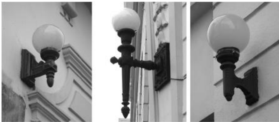
Figura 35:Luminárias em metal fundido, Fonte: Dametto, 2009
