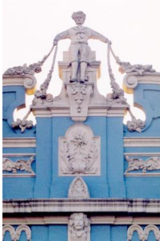
Figura 42: Detalhe da figura do marinheiro do frontão da fachada do palacete de Adriano Rocha Fonte: Noble et alii, 2012
