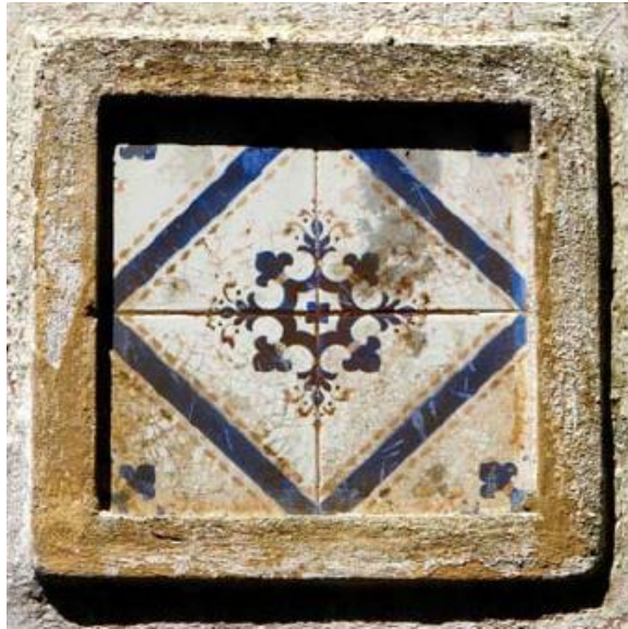
Figura 27: Exemplo de azulejo com eflorescências existente na Colônia Mazza, Fonte: Curval, 2008
