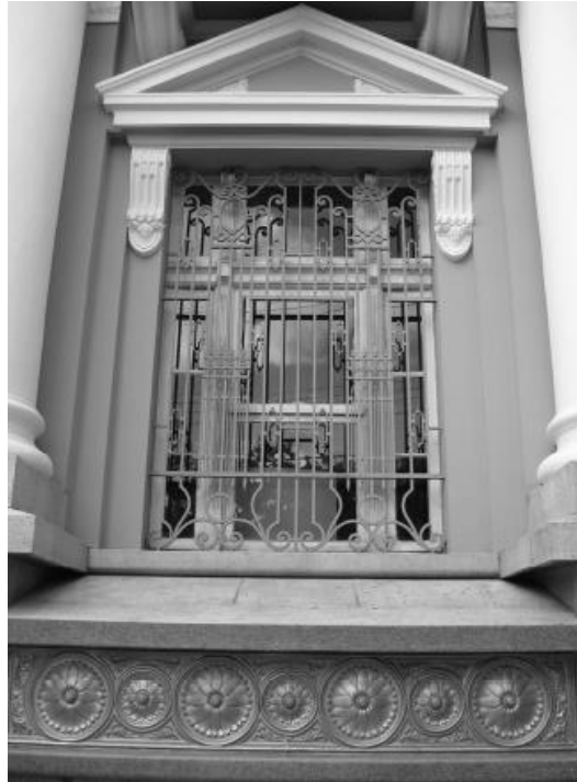
Figura 36: Grade em janela e faixa metálica sobre alvenaria. Sede do antigo Banco da Província. Fonte: Dametto, 2009
