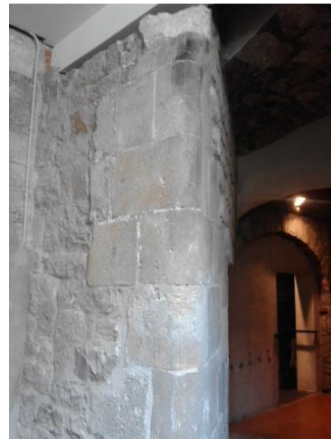
Conexión con el Tinell en el sótano 159
