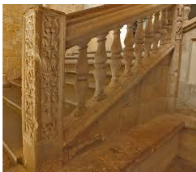
Detalle del arranque de la escalera. 154
