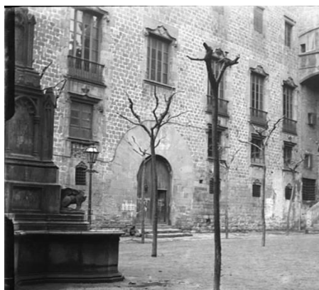
Fachada P. Lloctinent, plaza del Rei, 1918. 171
