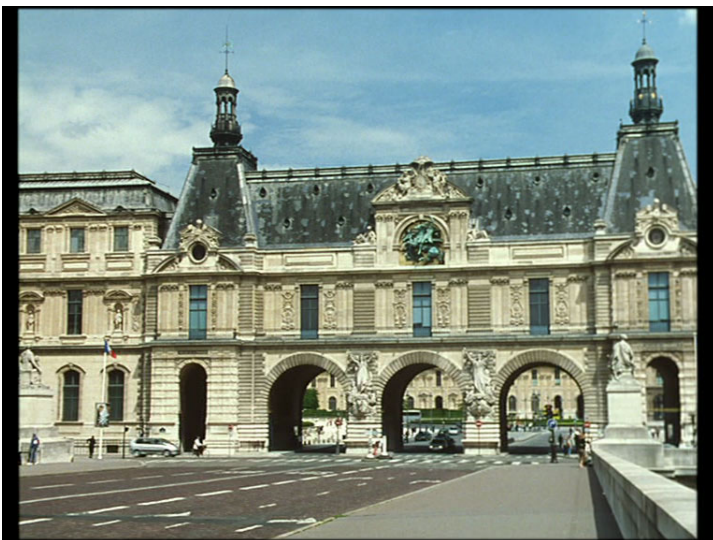
Figura 9: vista del Louvre en la primera escena del film Une visite au Louvre .
