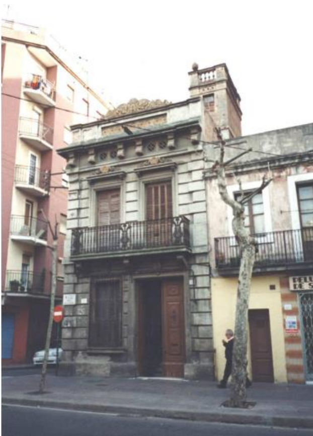
Façana principal edifici del carrer Enric Prat de la Riba. (Imatge extreta de la fitxa 20 del PEPPA)
