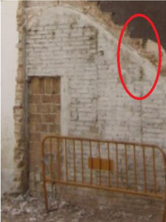
Detall façana Mas on s'observa com l'escala envaeix la traça original d'una obertura (Imatge extreta de l'AML'H)
