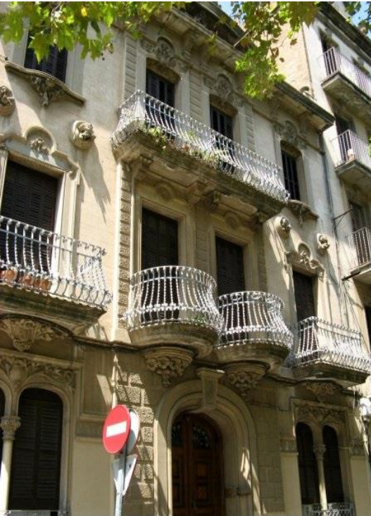
Façana principal Casa Josep Oliveras (imatge extreta de poblesdecatalunya.com)
