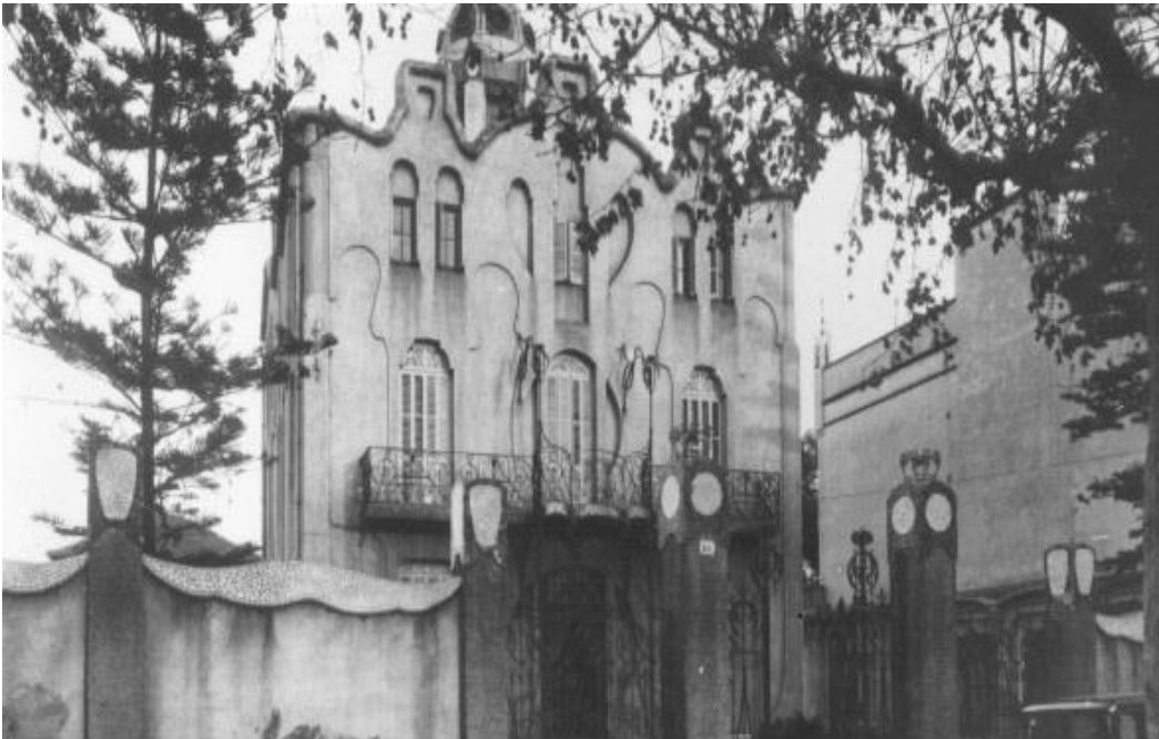
Vista de la primera façana on s'aprecia el trencadís dels murs (Imatge extreta de lhospitaletdellobregat.wordpress.com)
