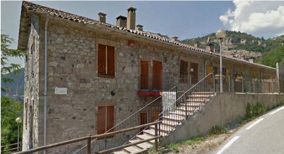
Fig.C 35: Edifici plurifamiliar de la colònia de Cercs amb accés en un nivell superior a les vivendes. Font: pròpia
