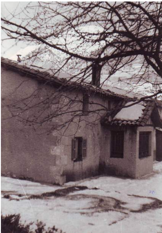
Fig.C 31: Fotografia de la Casa Wagner prèvia a la degradació. Font: Ramon Soler
