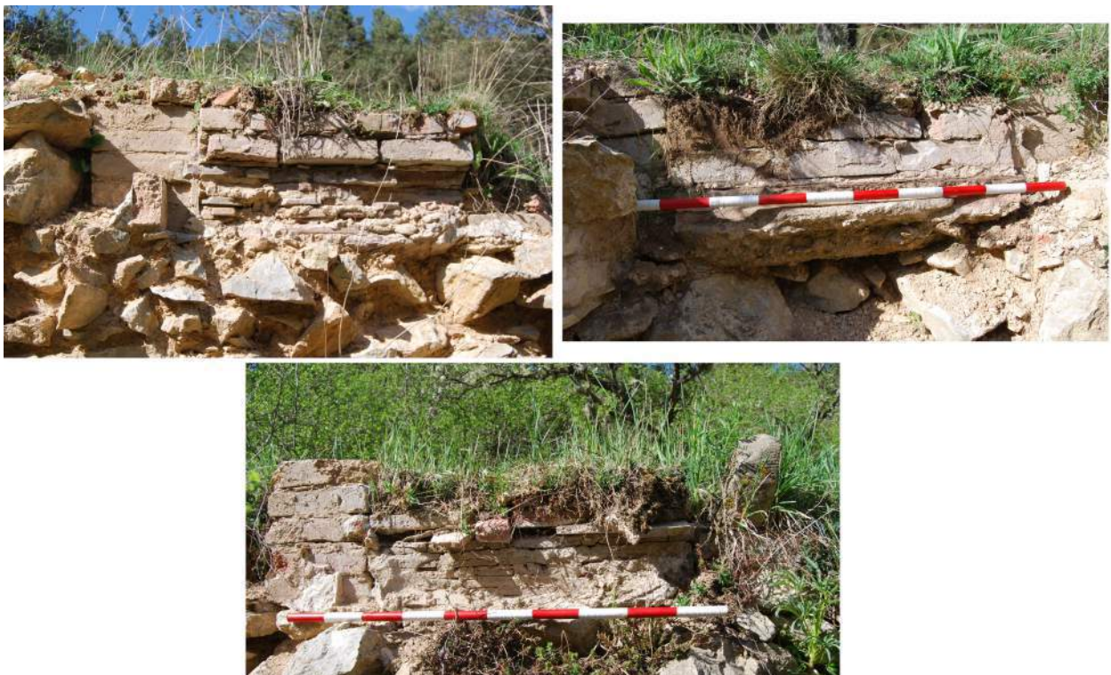
Fig.C 26: Possibles portes tapiades del Bloc A d'Els Pisos (d'est a oest). Font: pròpia
