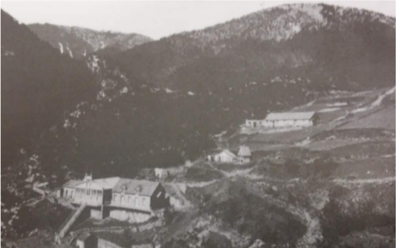
Fig.C 27: Fotografia antiga de la Colònia de la Vall: a baix a l'esquerra, la Torre de la Vall o Torre Moreta; a dalt a la dreta un dels edificis plurifamiliars. Font: Ramon Soler
