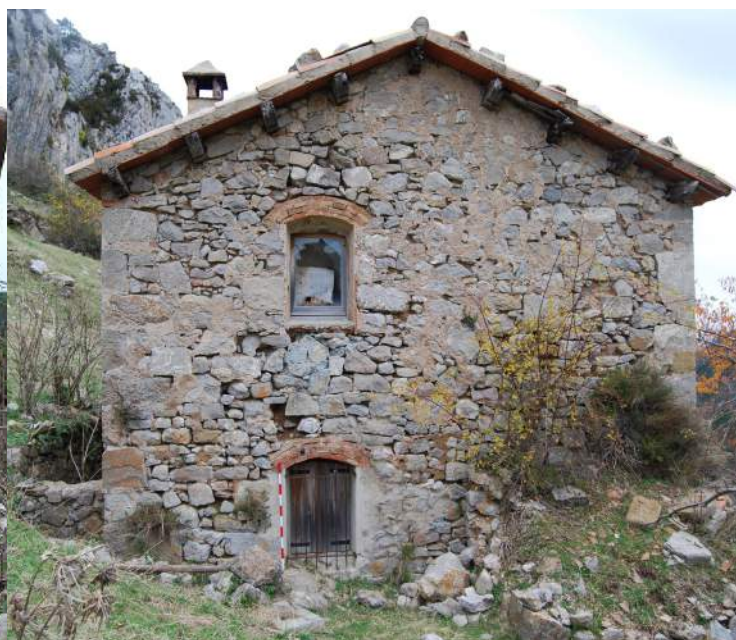
Fig.C 19: Façana lateral oest de Cal Gran. Font: pròpia
