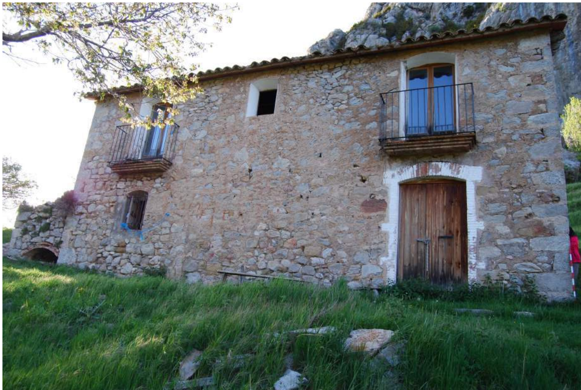
Fig.C 17: Façana principal de Cal Gran. Font: pròpia
