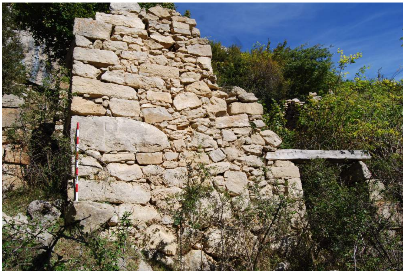
Fig.C 13: Façana principal de Cal Broquetes amb dintell de fusta. Font: pròpia
