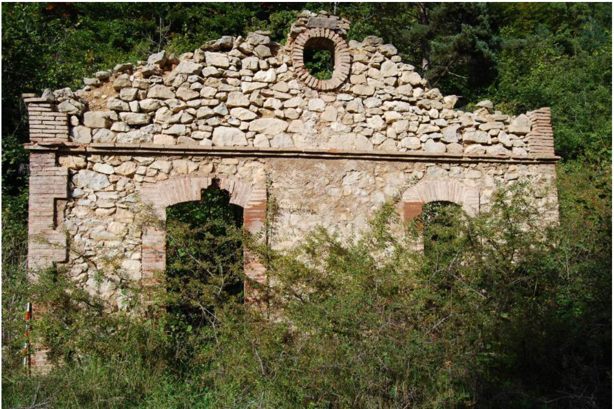
Fig.C 12: Façana principal de Cal Mamarruques, amb porta de maó. Font: Pròpia
