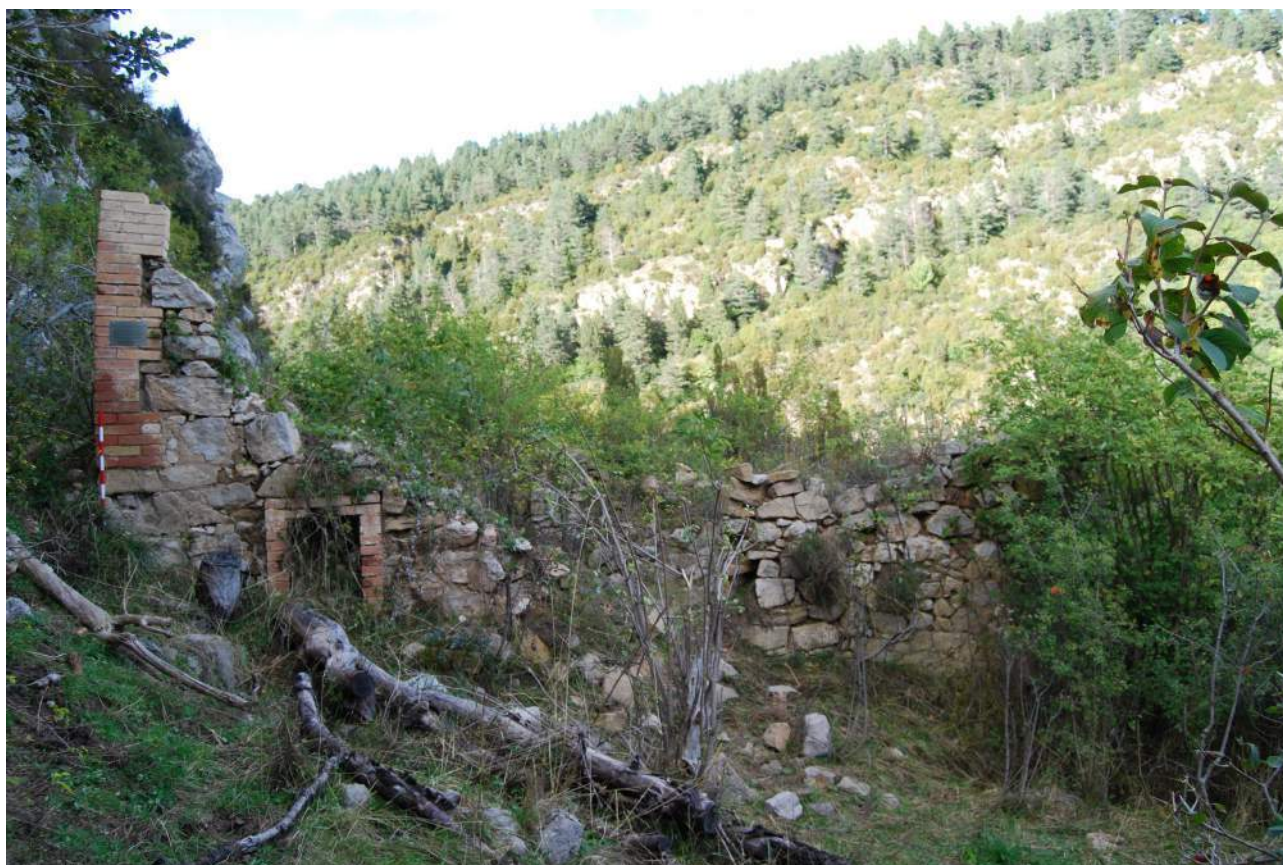
Fig.C 14: Façana principal de Cal Perón. Font: pròpia
