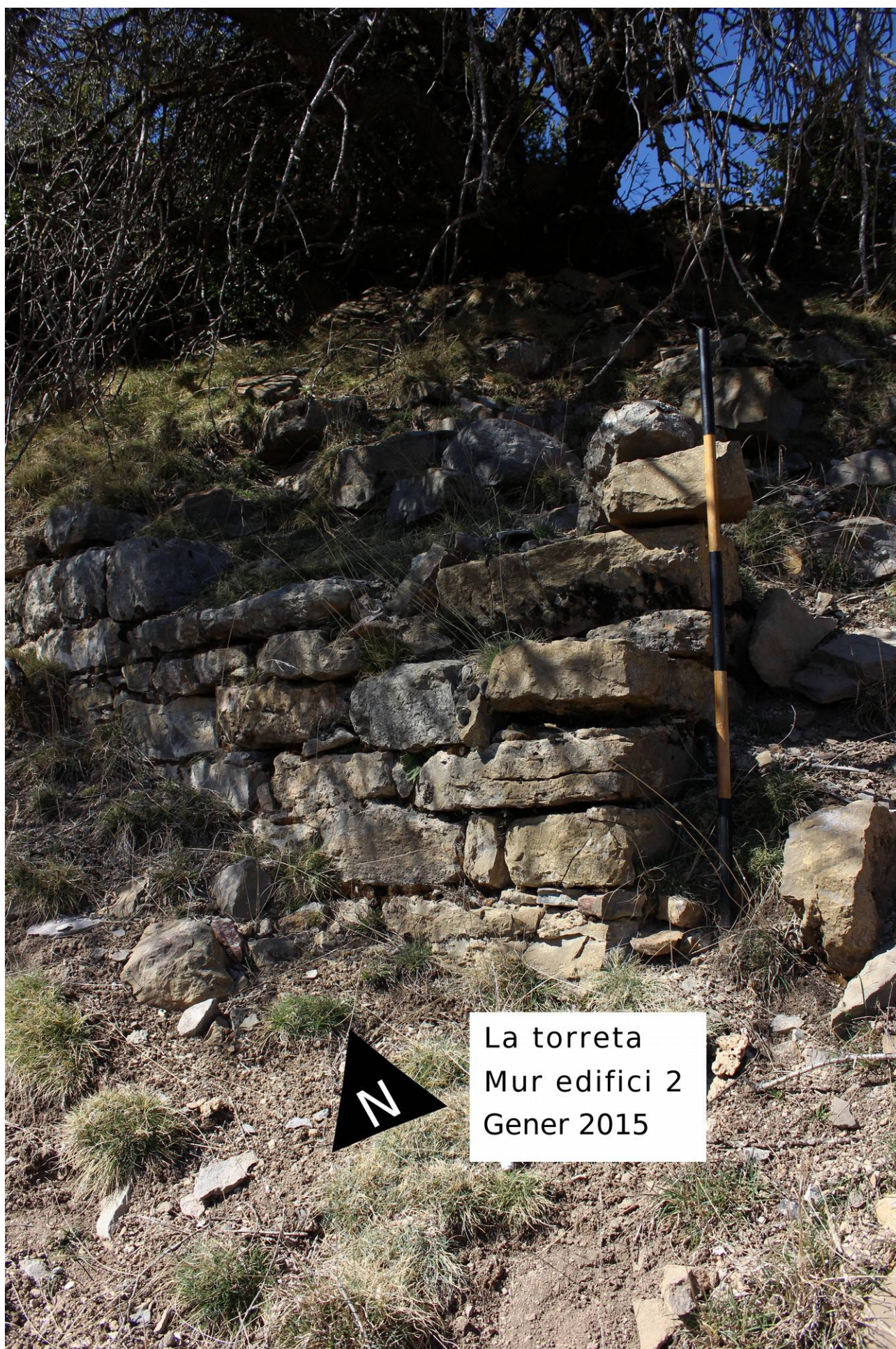
Fig. 15: Detall de la cantonada Sud-oest de l'edifici 2. S'observa el sistema constructiu en pedra seca, clarament diferent del de l'edifici 1.
