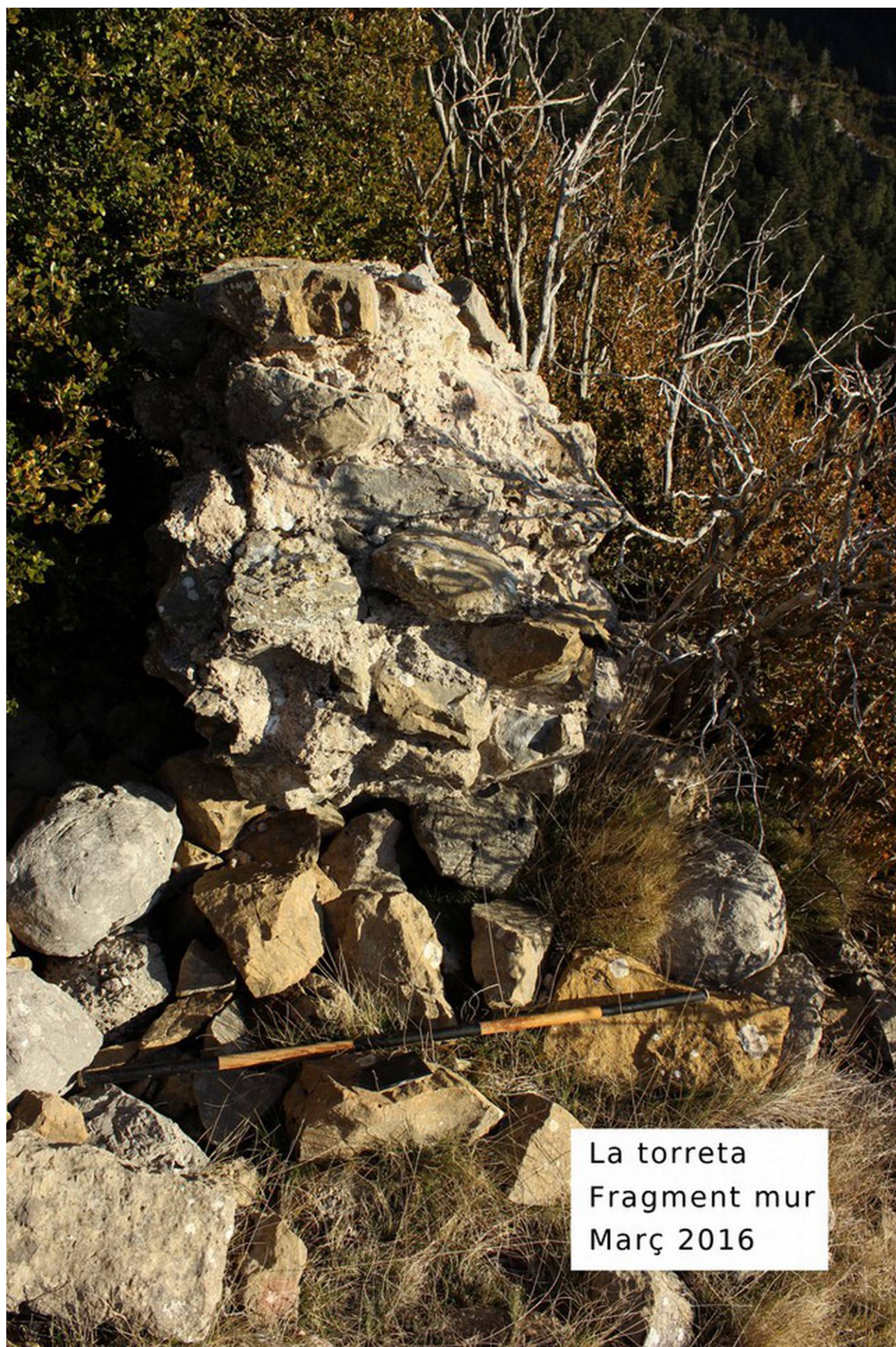
Fig. 14: Fragment de mur relligat amb morter, probablement procedent de l'enderroc de l'edifici 1.
