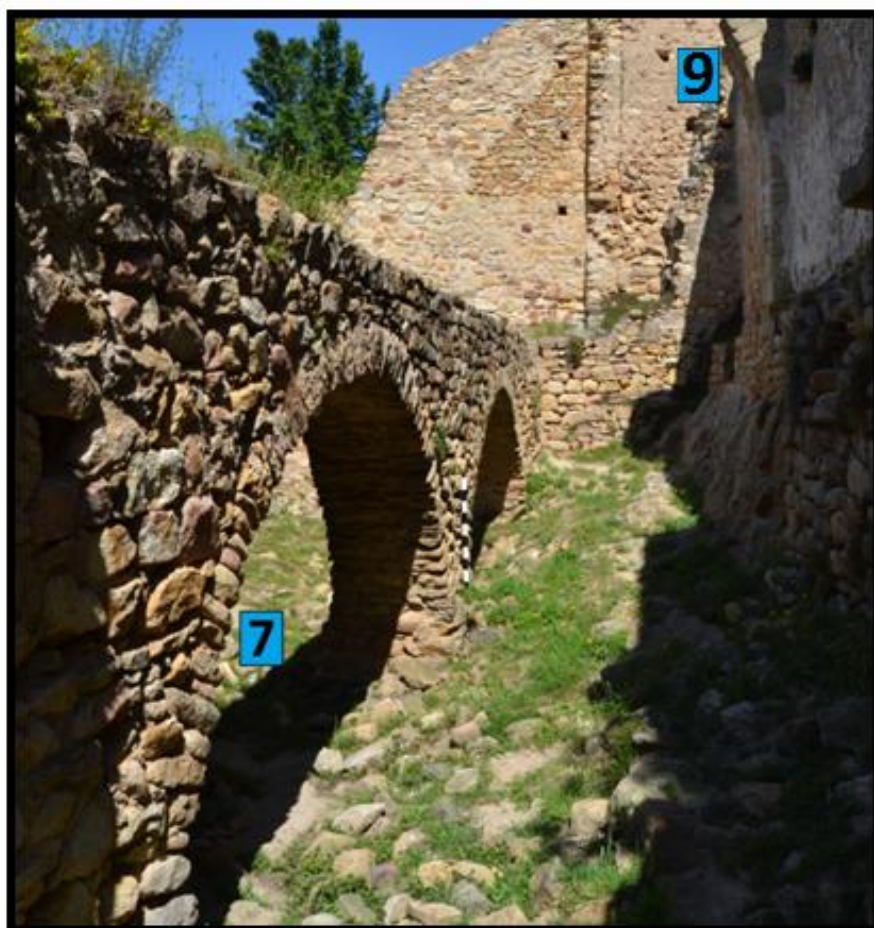
Fig.7: Sala conocida como bodega (nº7); dos arcos paralelos cruzan el área, también serian el sustento de otra sala superpuesta (nº9) (Foto de Fco. Calero Gallego).
