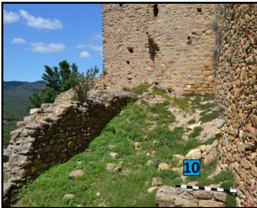
Fig.9: Zona que se ha entendido como patio interior (nº10), se puede observar desde la ventana de la habitación principal (nº17) (Foto de Fco. Calero Gallego).
