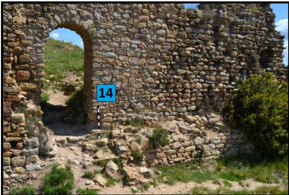
Fig.11: Puerta de acceso al recinto de habitaciones y torre del homenaje (Foto de Fco. Calero Gallego).
