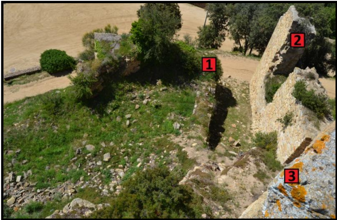
Fig.6 Premuralla (nº1) que reforzaba la protección del muro este (nº3) de la muralla y el negativo donde se ubicaba el puente levadizo que daba acceso a la fortaleza (nº2), (Foto de Fco. Calero Gallego).
