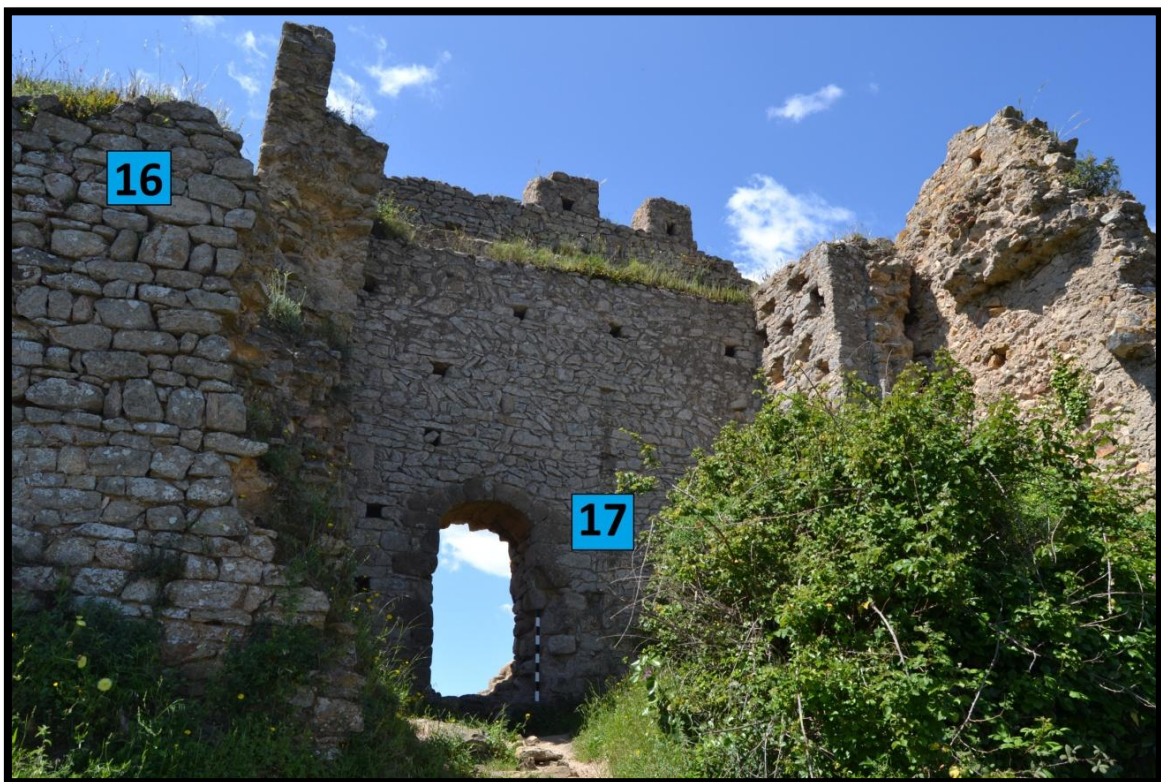
Fig.12: Torre del homenaje (nº16) colindante a la supuesta habitación señorial (nº17), destacar los detalles de las almenas. La altura de la que dispone el muro da a entender que habría otra sala superpuesta a la que se accedería desde la torre (Foto de Fco. Calero Gallego).
