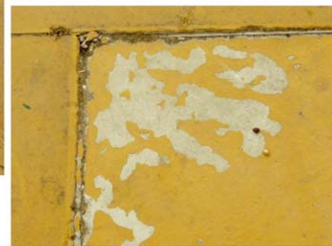
Figura 4. Pavimento de cemento pintado en el que la pintura se está desprendiendo. [En situaciones similares, ¿no sería más adecuado utilizar un cemento teñido en masa con el que se obtuviera la coloración deseada?].
