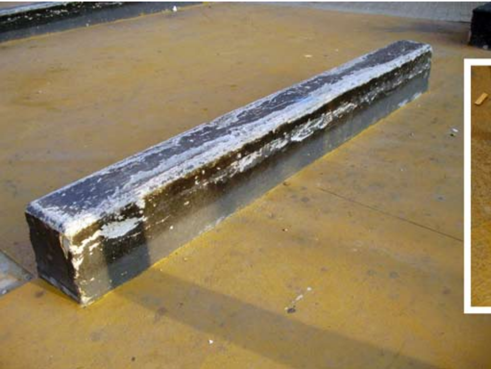
Figura 8. Banco de hormigón revestido con mortero y pintado en el que ha ido saltando la pintura y el revestimiento.
