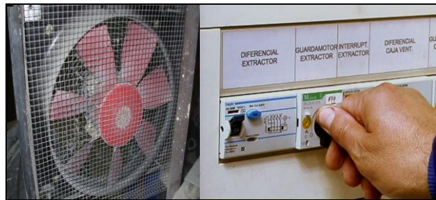
Fig. 4. Protecció col·lectiva, connexió del sistema d'extracció.
