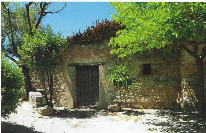
Fig. 12: Exterior del Aula Auxiliar. Fuente: Sales, Salazar, 2010, Vol. II, Anexo.
