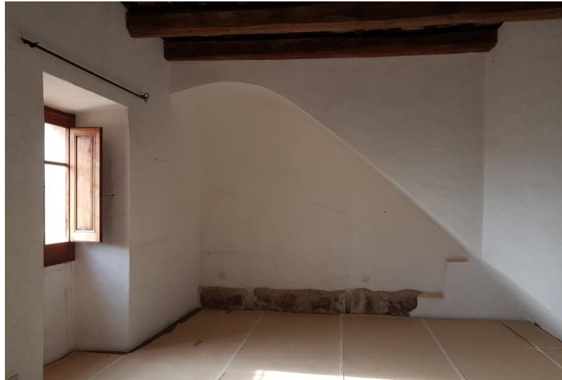
Fig. 17: Interior del Aula Maior. En la esquina inferior derecha pueden apreciarse los restos de la antigua escalera. Fuente: Chazarreta Illanes, M.
