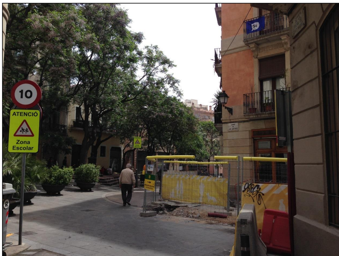
Figura 13. Tramo de calle de una zona escolar en obras en la Vila de Gràcia, 2017
