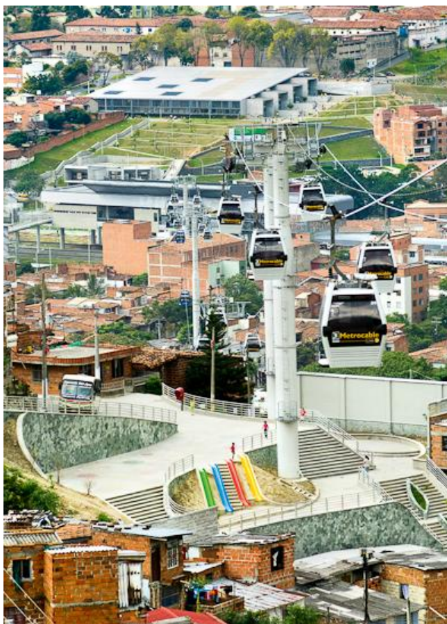
Imagen 10. Proyecto Urbano integral de la comuna 13, en primer plano el metrocable Línea J San Javier y el Parque Biblioteca San Javier. Foto: Julián Roldan.
