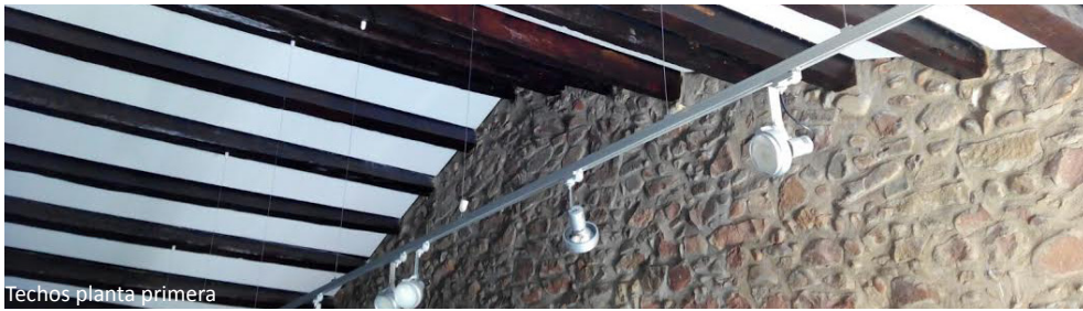
Techos planta primera
