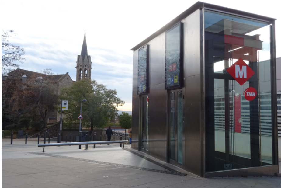
60. Acceso a los ascensores de la estación de Església Major de la línea 9 del metro. Fuente: elaboración propia.
