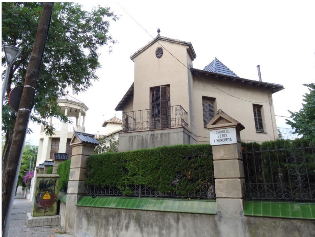
Fig.38. 1915.- Casa Barata construida por la cooperativa de periodistas de Barcelona en la ciudad-jardín de la Font d'en Fargues
