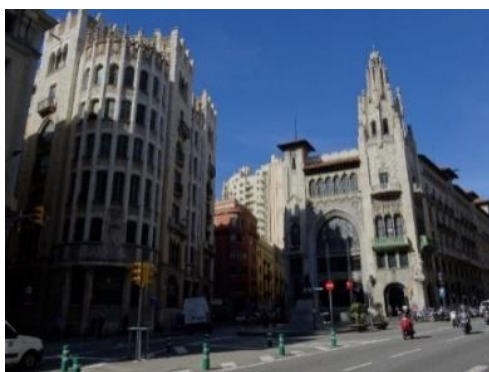
Fig. 76. Edificio de la Caixa de Pensions y del Casal de Previsió de la Caixa-. Enric Sagnier, 1911-1929. “Modernista”. Fuente: CR POLIS. Universitat de Barcelona
