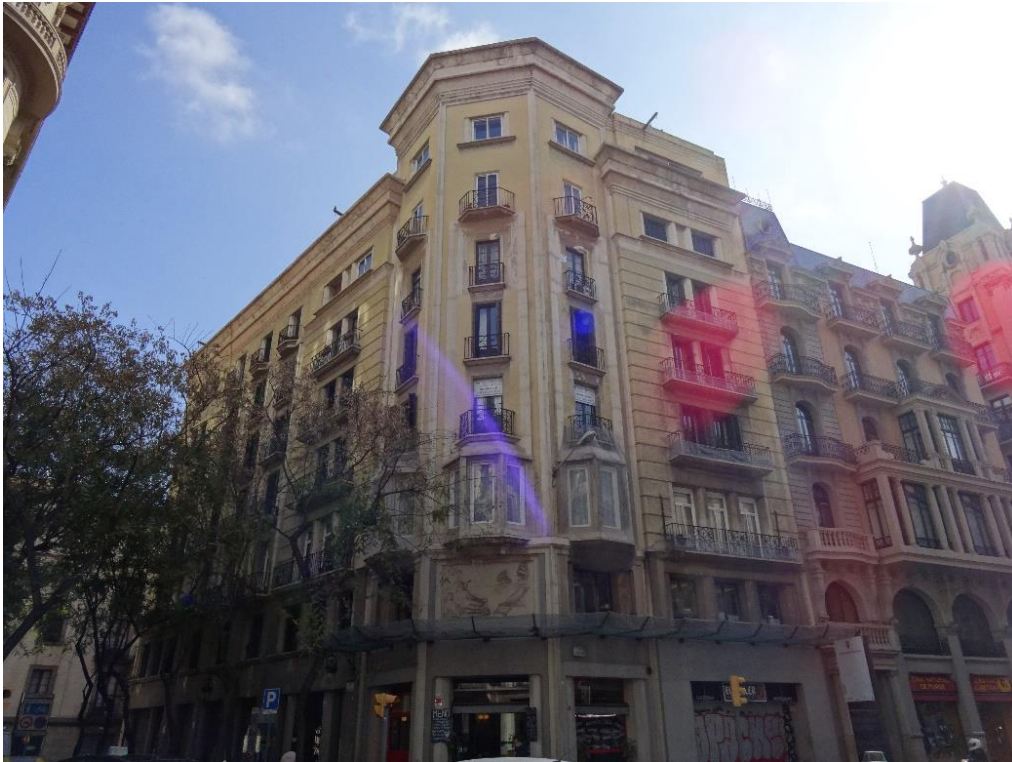
Fig.32. Vía Laietana 6. Casa de la Compañía de Seguros Barcelona. Antoni Puig-Gairalt (1928-1930). Puig-Gairalt es uno de los arquitectos clave para entender el paso del racionalismo a los postulados de la Arquitectura Nueva
