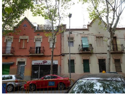
Casas plurifamiliares, generalmente de PB+1, en hilera
