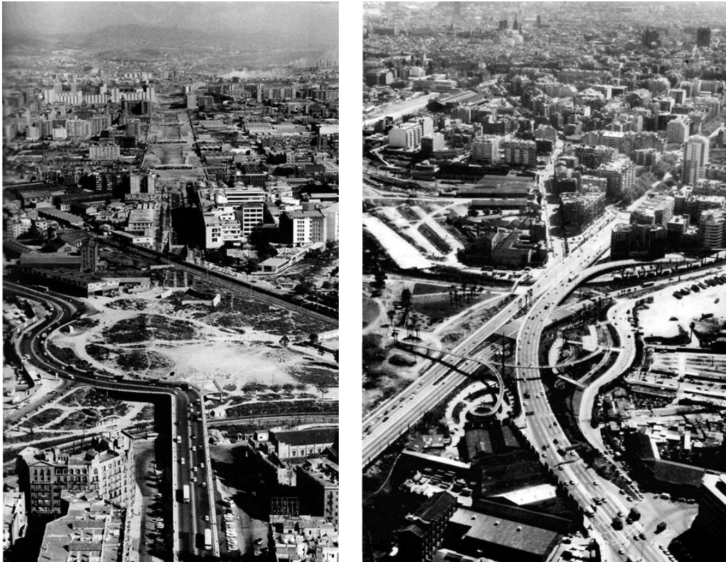
Fig. 156. Transformación de la Plaza de la Glòries en relación al conjunto de trabajos de subsuelo para desviar las conexiones ferroviarias según el plan de enlaces de 1966 y las viarias con la apertura de la parte este de la Gran Vía, Avenida Meridiana, Diagonal hacia Poblenou. Fuente: AFM de Barcelona.
