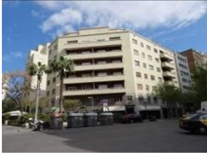
Fig. 100. Edificio de Viviendas. R. Churruga – G. Rodríguez Arias. 1934-1940. Fuente: CR POLIS. Universitat de Barcelona
