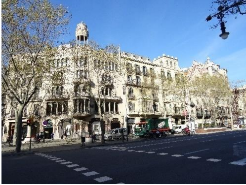
Fig.84. Casa Lleó Morera (1905). Lluís Domènech i Montaner
