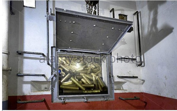
Almacén de casquillos de 75 mm. Caían por gravedad tras los disparos.
