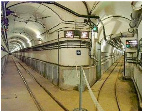
Bifurcación de galerías. Principal y secundaria
