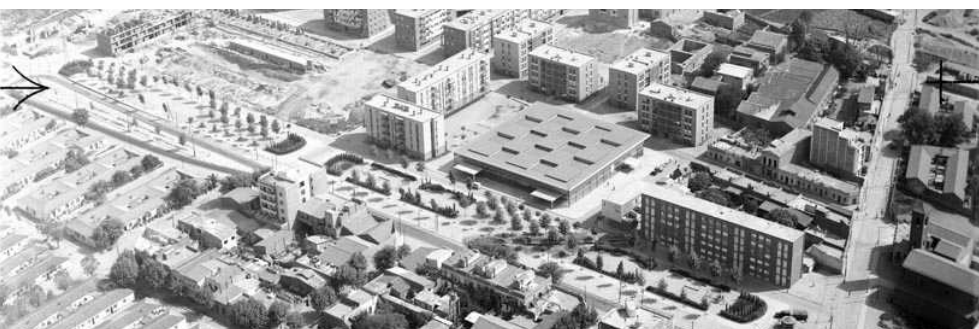
Fig. 2.25 Vista aérea de la zona, 1962. Se muestra la extensión del Paseo Sant Adrià.
