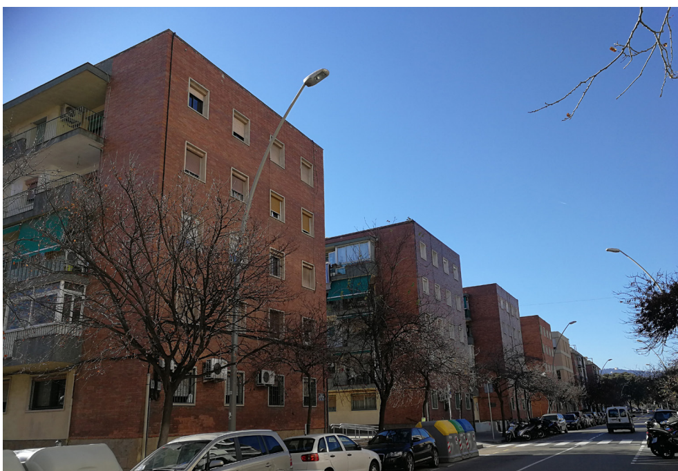
Fig 2.15 Fotografía estado actual edificaciones parcela B.
