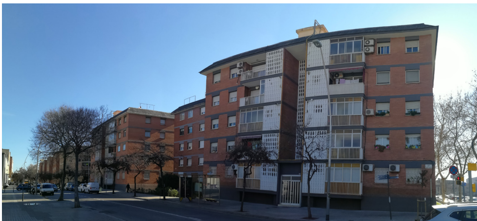
Fig 2.14 Fotografía estado actual edificaciones parcela A.
