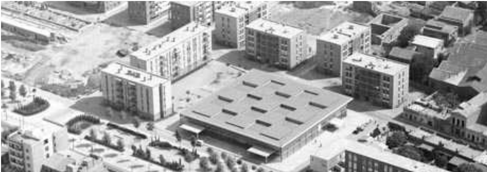
Fig 2.18 Vista área de la zona, 1962. Bloques parcela E emplazados en "L", colindantes al mercado del barrio.
