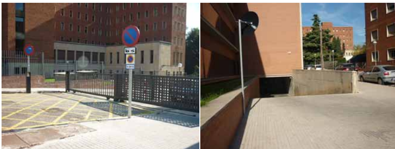
Figura 34. Barrera d'accés a l'aparcament de la Facultat de Biologia entre l'edifici Annex i la Residència Universitària (esquerra) i portalló d'entrada a l'aparcament subterrani de l'edifici Annex (dreta). Font: Banc d'imatges OSSMA (04/11/2010).
