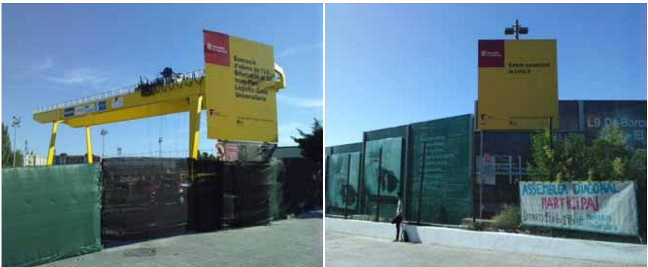
Figura 101. Senyalització de les obres de l'119 a les estacions de Campus Sud (esquerra) i Zona Universitària (dreta). Font: Banc d'imatges OSSMA (26/10/2010).
