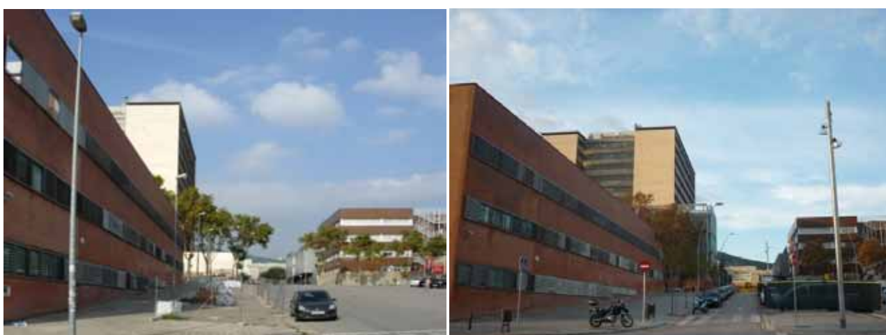
Figura 96. Vista del carrer de Pascual i Vila a la cantonada amb Llorens Artigas l'1/11/2006 (Alegre i Roca, 2007) i l'1/12/2010, després de la urbanització del vial (Banc d'imatges OSSMA).
