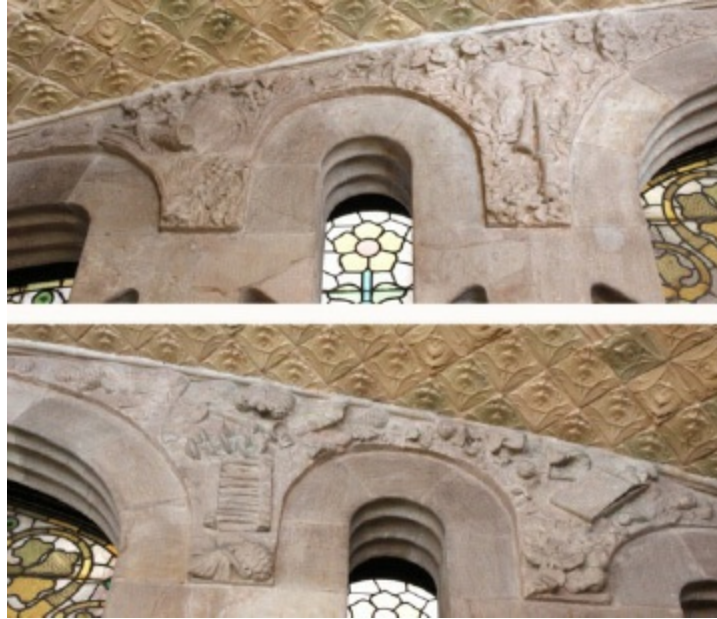
Fig. 1. Dos dels timpans a l'escala principal del Palau de la Música. Fotografia de Florencia Barcina.
