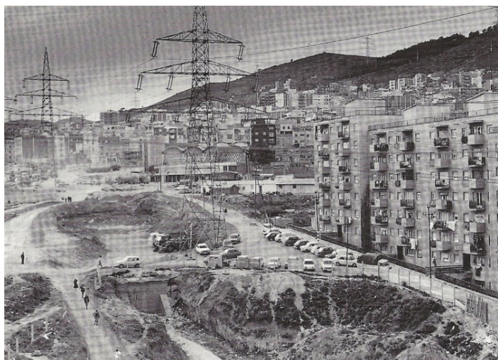
IMATGE 3: CONSTRUCCIÓ DE NOU BARRIS
