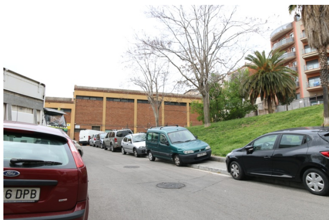
IMATGE 20: ENTRADA A LA ZONA DE CÀRREGA I DESCÀRREGA - C/ PORT DE LA SELVA
