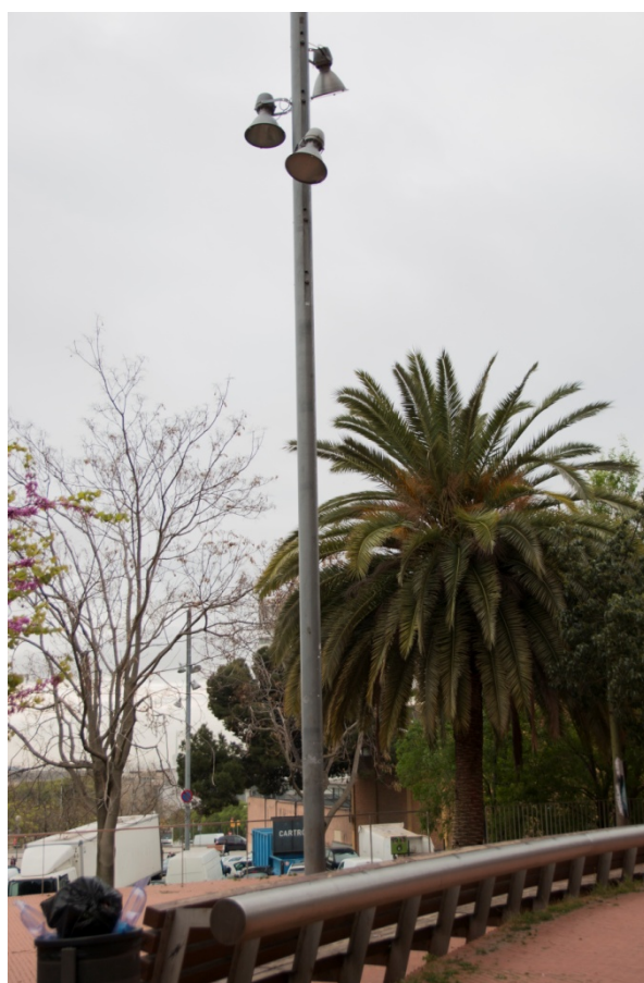
IMATGE 62: ELEMENT D'ENLLUMENAT EN LA ZONA D'ESTADA
