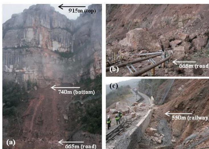
Fig. 1: a) Desprendiment produït el 28 de desembre de 2008 de 883 m 3 a la paret de Degotalls N. b) Impacte del desprendiment a la carretera . c) Impacte del desprendiment a les vies del tren cremallera. Les elevacions estan en m s.n.d.m. Imatge extreta de Janeras et al., (2017).
