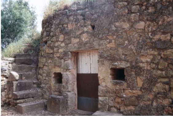
Fig. 84. Barraca de marge amb juntes reomplertes amb argamassa i incorporació d'una porta. Barraca 139 del PEP del terme municipal de Montblanc. Manel Martínez.
