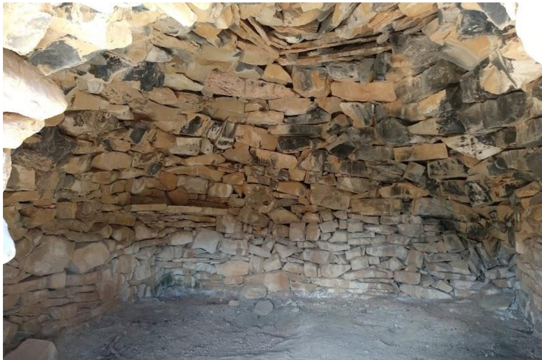
Fig. 10. Barraca de falsa volta del terme municipal de Montblanc. Es pot observar, als laterals, la distribució de les pedres en forma de petxina, que permeten passar de la base quadrada de la construcció a la forma rodona de la volta. Font pròpia.
