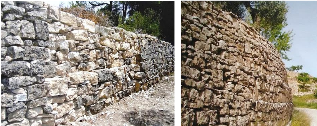
Fig. 90 i 91. Sistema de reintegració per esglaonatat o canvi de nivell. Rebés i Reguant.
