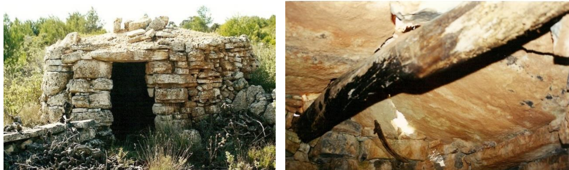
Fig. 21 i 22. Coberta plana de cabirons de fusta i lloses. Barraca 049 del PEP del terme municipal de Montblanc. Manel Martínez.
