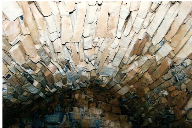
Fig. 14. Cabana de volta de canó 083 del Pla Especial de Protecció del terme municipal de Montblanc. Volta de canó de pedres planes i rectangulars. Manel Martínez.
