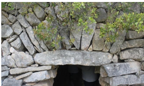
Fig. 41. Col·locació d'una filera de pedres en rastell. Barraca del PEP del terme de Montblanc. Font pròpia.
