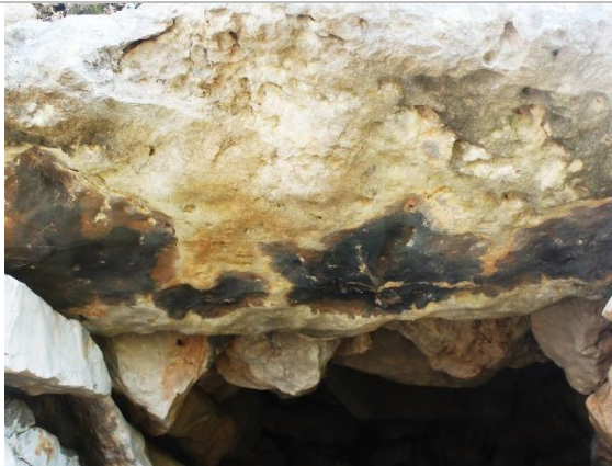
Fig. 66. Taques d'humitat. Font pròpia.
