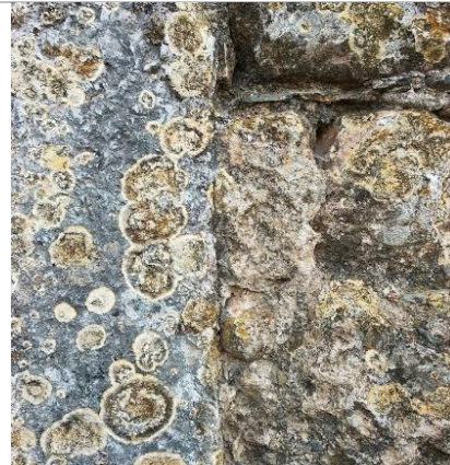
Fig. 67. Clapejat provocat per líquens. Font pròpia.
