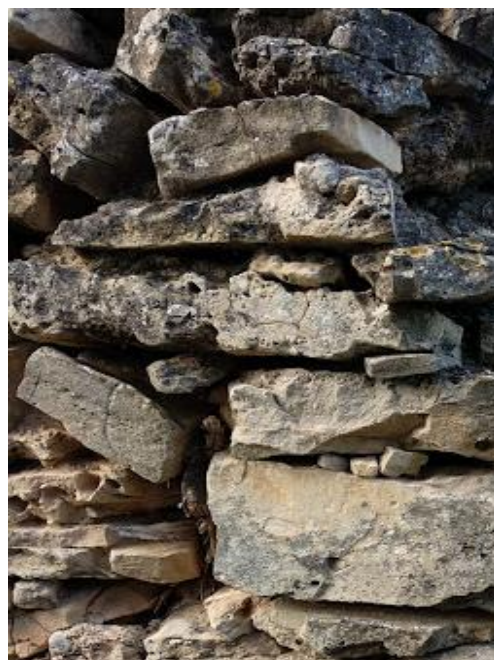
Fig.1. Detall d'una construcció de pedra seca. Font pròpia.
