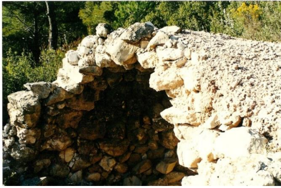
Fig. 15. Exterior d'una barraca de mitja volta. Barraca 038 del PEP del terme municipal de Montblanc. Manel Martínez.
