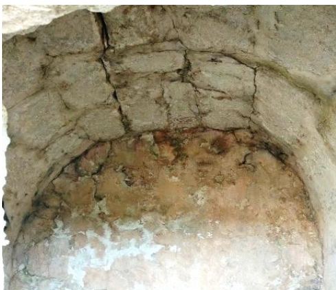
Fig. 13. Cabana de volta de canó 079 del Pla Especial de Protecció del terme municipal de Montblanc. Volta de canó amb carreus treballats. Font pròpia.
