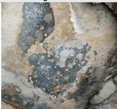
Fig. 59. Colonització biològica: bacteris i fongs. Font pròpia.
