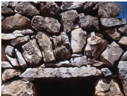
Fig. 39. Arc de descàrrega sobre la llinda del portal. Barraca 136 del PEP del terme de Montblanc. Manel Martínez.
