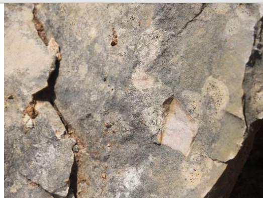
Fig. 56. Despreniment en estellat. Font pròpia.
