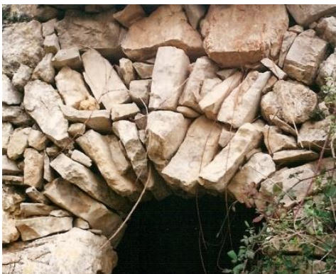
Fig. 38. Arc de descàrrega sobre l'arc del portal. Barraca 018 del PEP terme de Montblanc. Manel Martínez.
