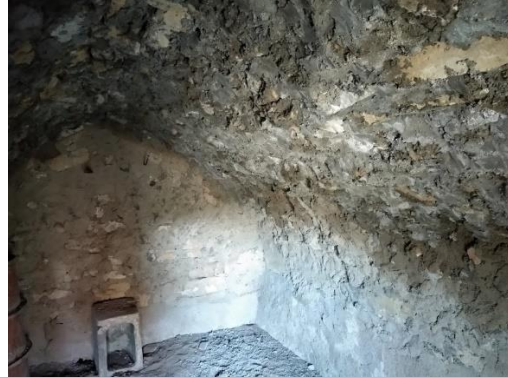
Fig. 85. Barraca amb juntes reomplertes amb morter de ciment. Barraca del PEP del terme municipal de Montblanc. Font pròpia.
