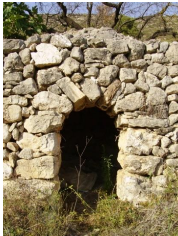
Fig. 31. Portal d'arc de mig punt. Barraca 019 del PEP del terme de Montblanc. Manel Martínez.
