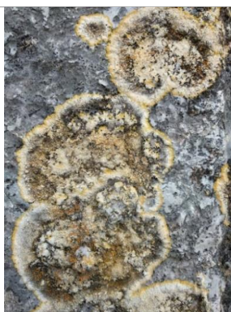
Fig. 61. Colonització biològica: líquens. Font pròpia.
