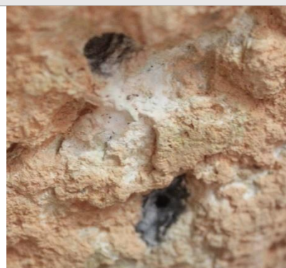
Fig. 60. Colonització biològica: nius d'insectes. Font pròpia.
