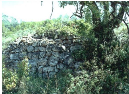
Fig. 79. Esfondraments per colonització de plantes superiors. Barraca 078 del PEP del terme municipal de Montblanc. Manel Martínez.
