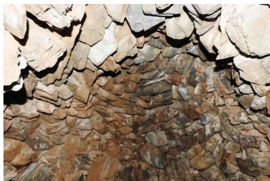
Fig. 18. Barraca de volta mixta 091 del PEP del terme municipal de Montblanc. Manel Martínez.
