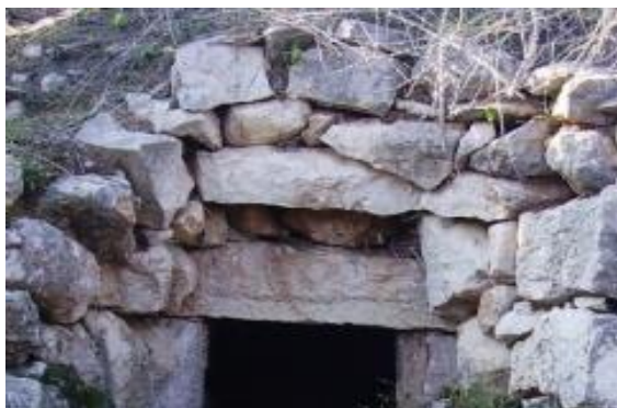
Fig. 40. Doble llinda. Barraca 024 del PEP del terme de Montblanc. Manel Martínez.
