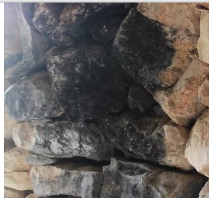
Fig. 58. Dipòsit de sutge. Font pròpia.
