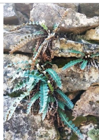
Fig. 63. Colonització biològica: plantes superiors. Font pròpia.
