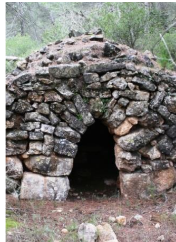
Fig. 33. Portal d'arc ametllat. Barraca 006 del PEP del terme de Montblanc. Manel Martínez.
