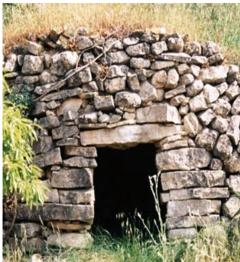
Fig. 35. Muntants verticals sostenint una llinda. Barraca 028 del PEP del terme de Montblanc. Manel Martínez.
