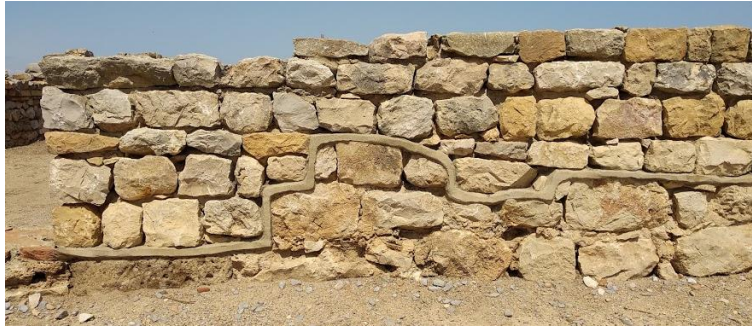
Fig. 89. Sistema de diferenciació de la reintegració per una franja de morter. Jaciment d'Empúries. Font pròpia.
