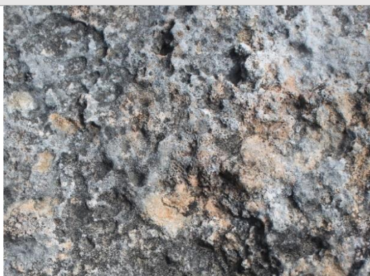
Fig. 53. Erosió alveolar i corrosió de la pedra. Font pròpia.
