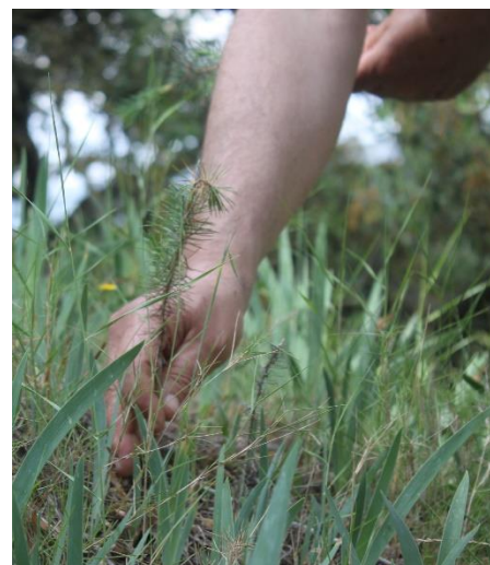
Fig. 88. Manteniment de la coberta d'una barraca. Eliminació d'un brot de pi. Font pròpia.
