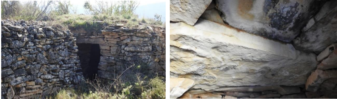
Fig. 19 i 20. Coberta plana de lloses. Barraca 096 del PEP del terme municipal de Montblanc. Manel Martínez.
