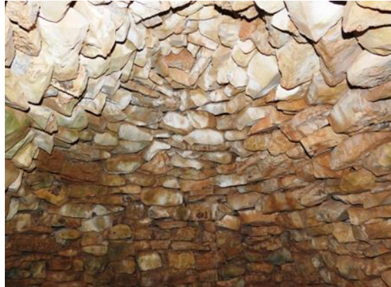
Fig. 9. Barraca de falsa volta 097 del Pla Especial de Protecció del terme municipal de Montblanc. Volta acabada amb clau. Manel Martínez.
