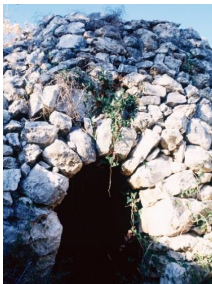
Fig. 37. Muntants arquejats que formen part de l'estructura de l'arc del portal. Barraca 053 del PEP del terme municipal de Montblanc. Manel Martínez.
