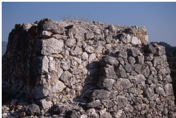
Fig. 7. Barraca de falsa volta amb una doble paret al darrere per facilitar la construcció de la volta. Fa també la funció de contrafort. Barraca 144 del PEP del terme municipal de Montblanc. Manel Martínez.
