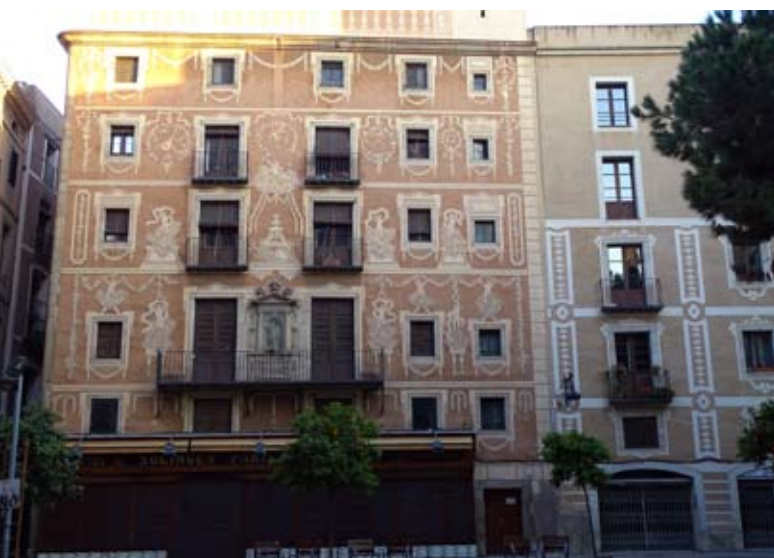
1781. Esgrafiados del edificio del antiguo Gremio de Revendedores.
