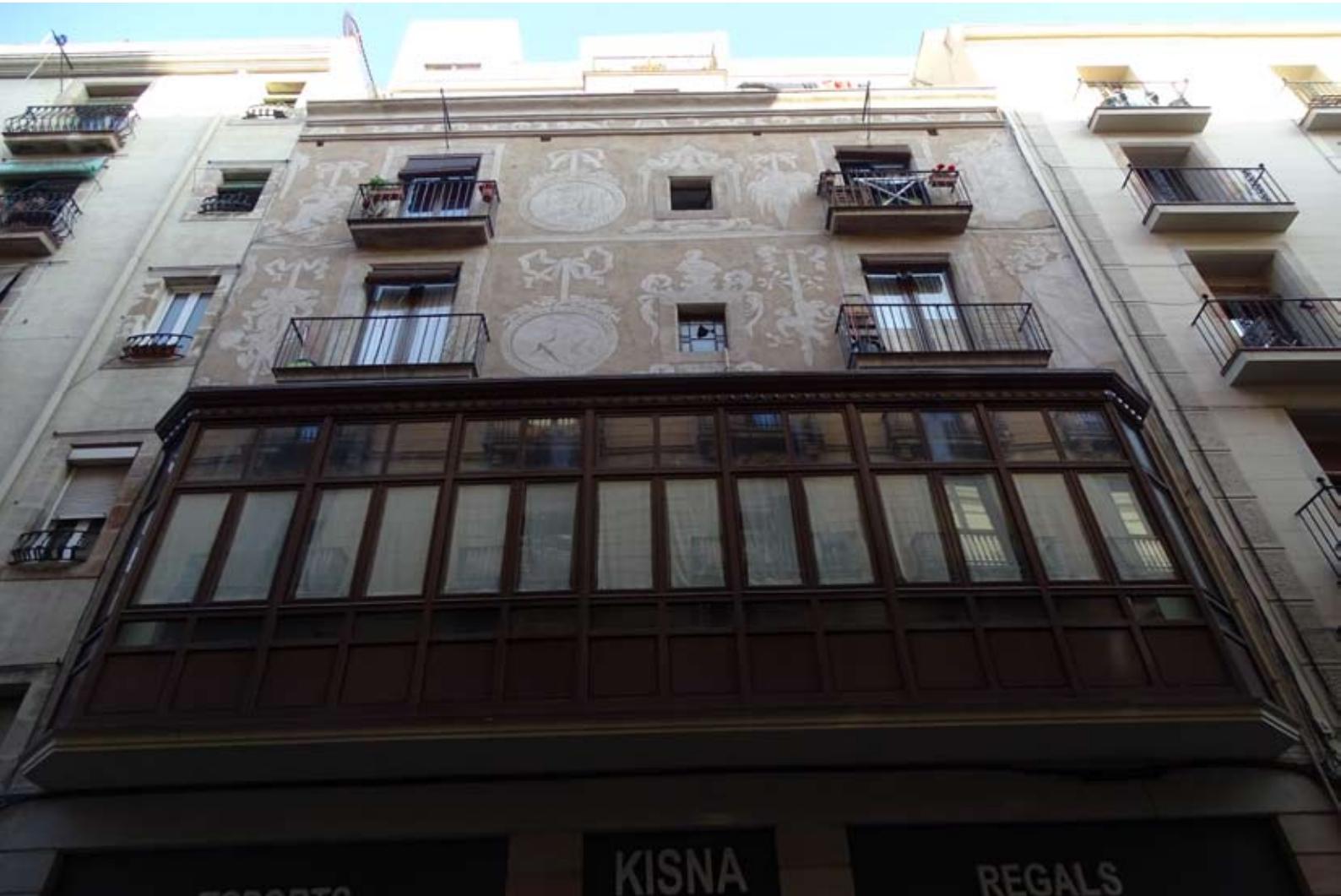
Mirador en la calle Nou de la Rambla, no sabemos a ciencia cierta si es de aquel periodo, pero es uno de los pocos existentes en edificios de la época, antes de la eclosión de los miradores modernistas.
