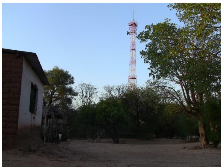
Ilustración 44 Nueva antena telefónica en La Brecha (Alto Isoso)
