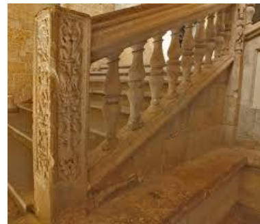
Arranque de la escalera. 401
