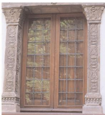
Jambas de la ventana. Terracota. 367
