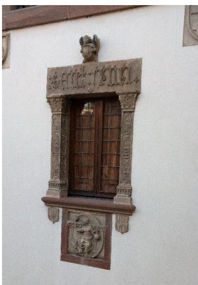
Jambas de la ventana. Terracota. 365
