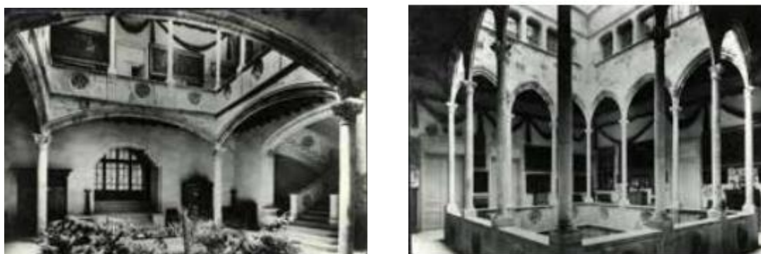
Casa Gralla. Patio. Plantas baja y superior. Casa Brusi. c. 1936. 308
