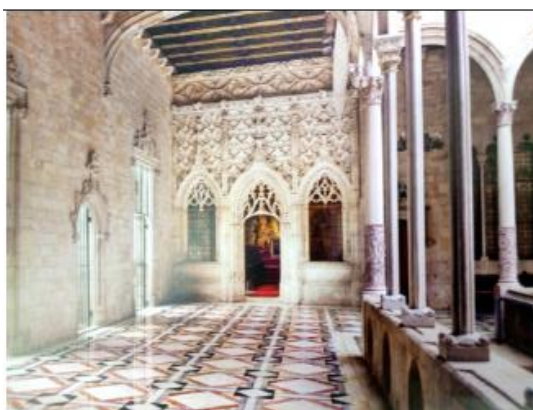
Fachada de la capilla gótica en su nuevo emplazamiento. 335
