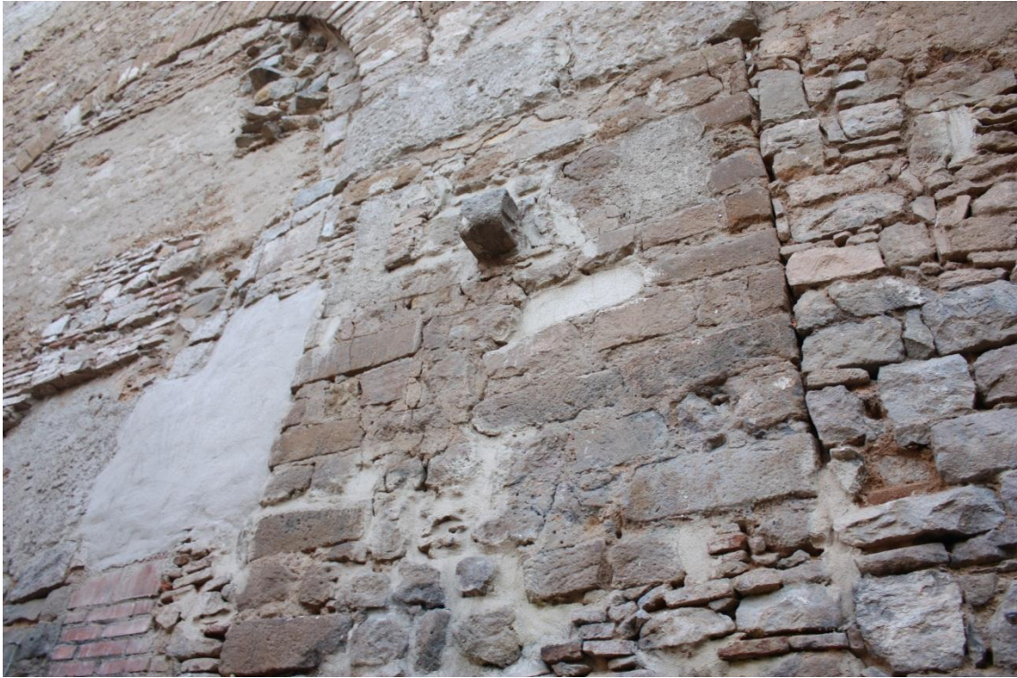
Fig. 7.7. Suport de biga del tercer pilar (A. López)
