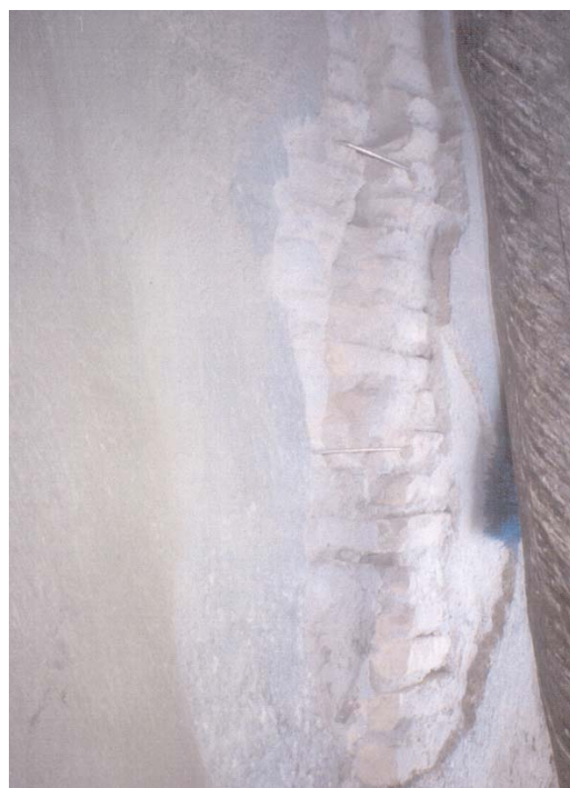
Rehabilitación de la cúpula central en 1999. Detalle del cosido exterior de una grieta.
