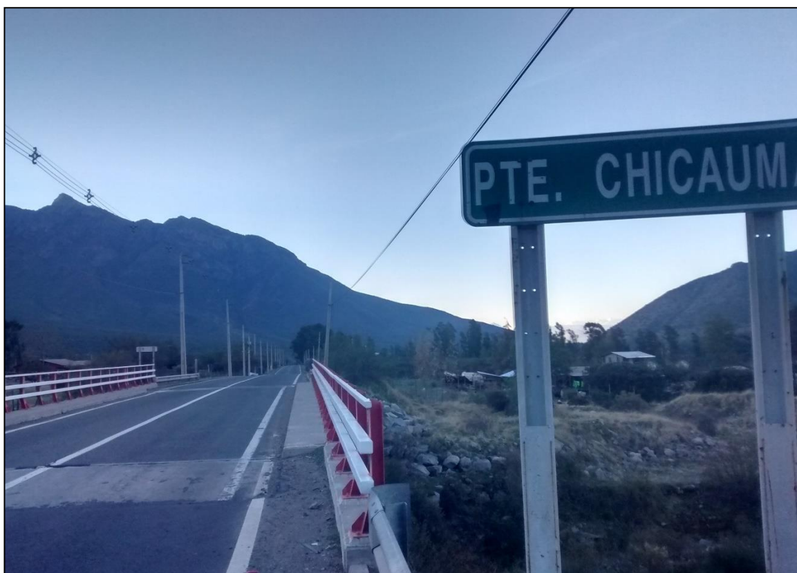
G.07. Puente Chicauma sobre ruta G-16 o Camino Chicauma (dirección sur – norte). (Fuente: Propia, 21/09/2018).
