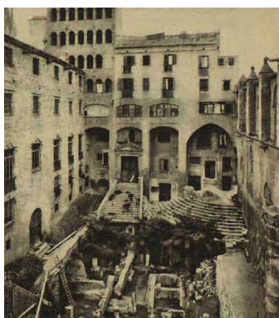
2.3.3. Excavaciones en la Plaza del Rey
