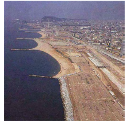
1.1.7. Trabajos de regeneración de las playas
