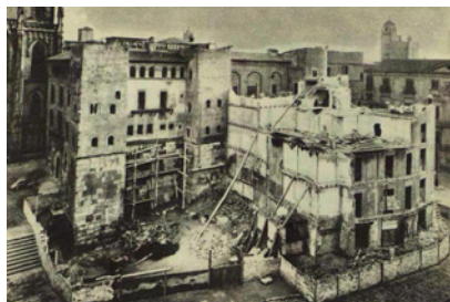
2.3.1. Derribo de edificios para la construcción de la Avenida de la Catedral
