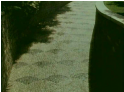
2.3.10. Detalle pavimento Passeig Mare de Déu del Coll 41
