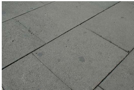
P04 Losa 40x60x8 Hormigón
