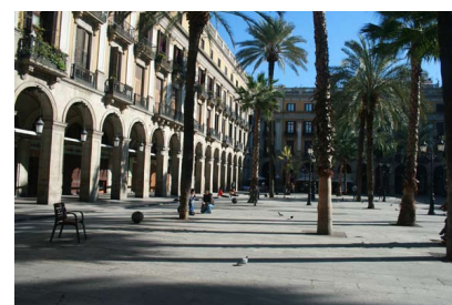
3.2.3. Estado actual de la Plaça Reial
