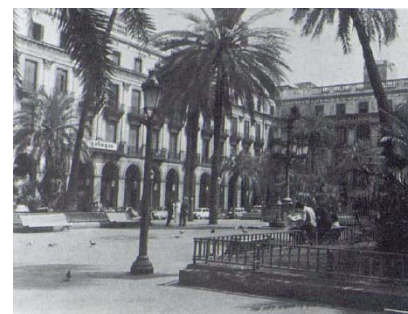
3.2.1. Estado de la plaza antes de la reforma
