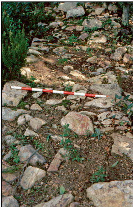
Figura 7. La muralla, al sector nord-est
