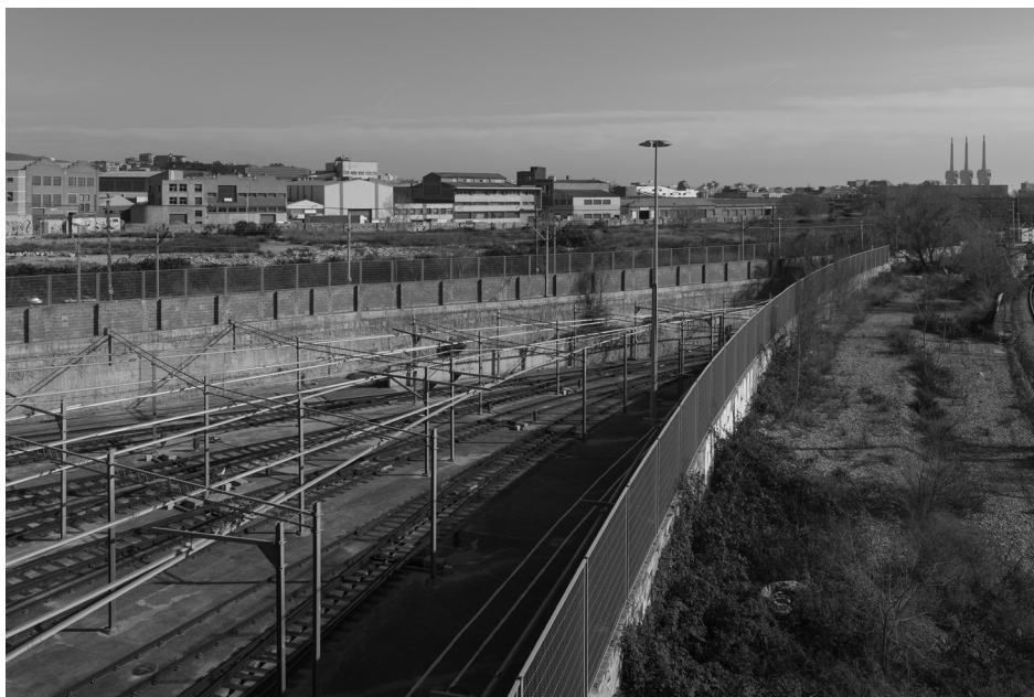
Figura 16: El triángulo ferroviario (Lonas de la desembocadura 3)
