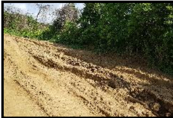
Figura 31. Vía con Tierra Dispareja
