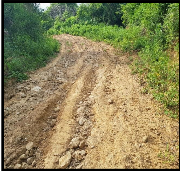
Figura 29. Vía con Ripio Disparejo
