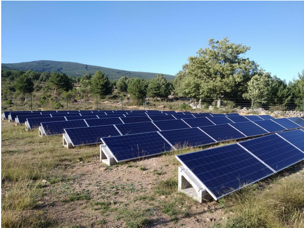
Imagen 8: las placas solares del pozo de captación de agua. Cedida por Ángel Sáenz Jiménez.
