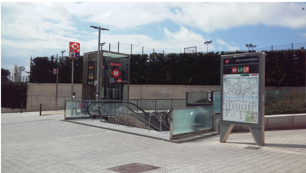
FIGURA 3. Nova entrada de la parada de metro de "Zona Universitària" per accedir a les línies L9 i L3, a la cantonada entre l'Avinguda Dr. Marañón i l'Avinguda Diagonal.
