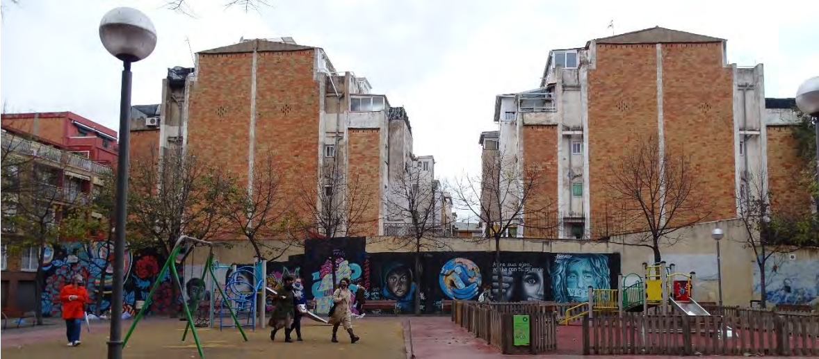
Fotografía de autora, medianeras Plaza Félix Rodríguez de la Fuente, Barrio el Bon Pastor.
