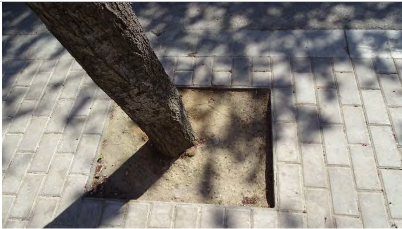
Alcorques pequeños a los lados de la plaza. Medidas: 59 cm X 80 cm
