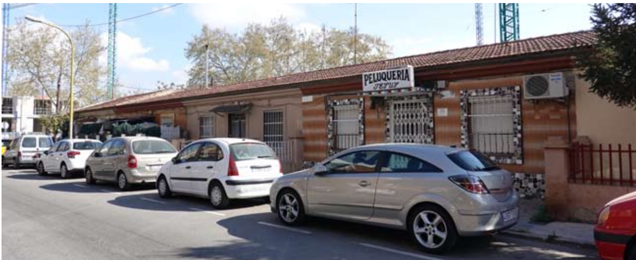
Vista actual de las casas baratas todavía existentes a espera de su demolición en la Fase V del proceso de remodelación . Fuente: CR Polis
