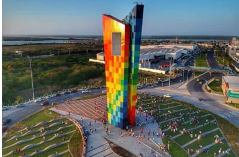
*Ventana al mundo* (Acero almallena A572-GR.50 y tubería estructural A500-GR.C y vidrio de colores) de Diana Escorcía 47,5 m altura. 2018. Fuente: Smart Steel co.
