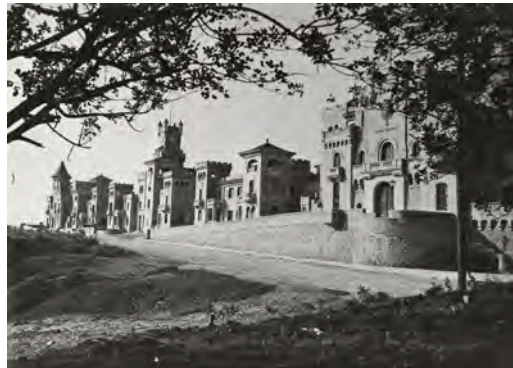
Fig. 35: View of Cuartel del Bruc (1934). Source: Arxiu Fotogràfic de Barcelona. Site no.14 on the itinerary.
