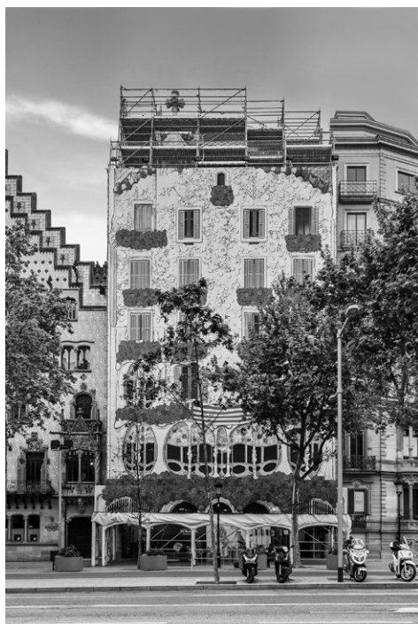
FIGURA 5. Lona mimética con las rosas en Sant Jordi de 2019 durante la restauración de la fachada. Fotografía: Casa Batlló.
