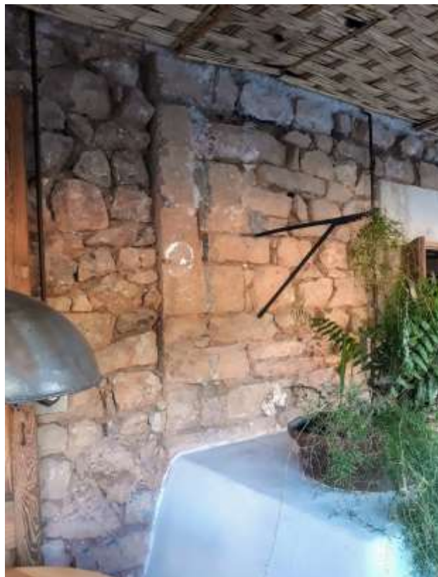
Fig. 9: Fotografia de detall de la paret original fet amb pedra als anys 50. Font: autoria pròpia (2021).
