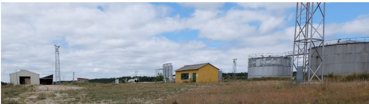
Figura P4.5. Instal·lacions en superfície ("facilities"), on es produïa la separació del cru i de l'aigua i l'emmagatzematge de cru, entre d'altres funcions (veure Fig. P4.6 ).
