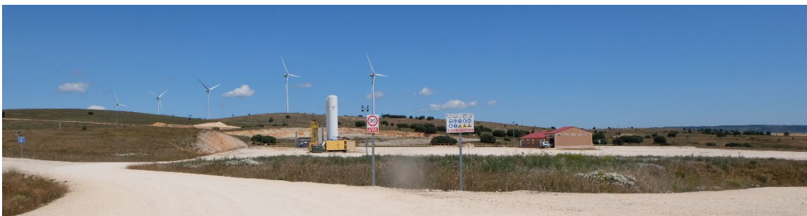
Figura P6.1. Instal·lacions de la planta de la Fundación Ciudad de la Energía (Ciuden) per la injecció de CO 2 en el reservori d'Hontomín.
