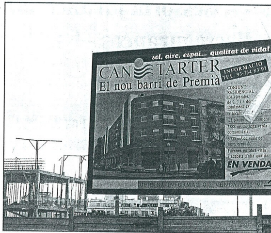
Els primers edificis previstos s'estan aixecant als carrers Mercè i Cisa.
