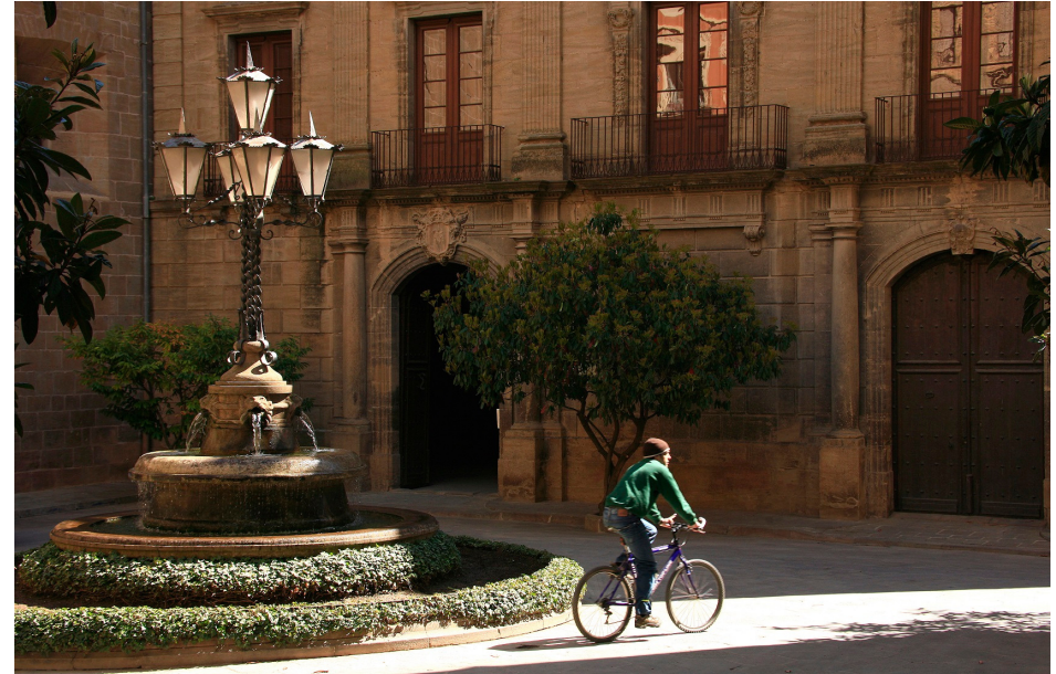
Façana del Palau Episcopal de Solsona, edifici que acull el Museu. Foto: Museu de Solsona
