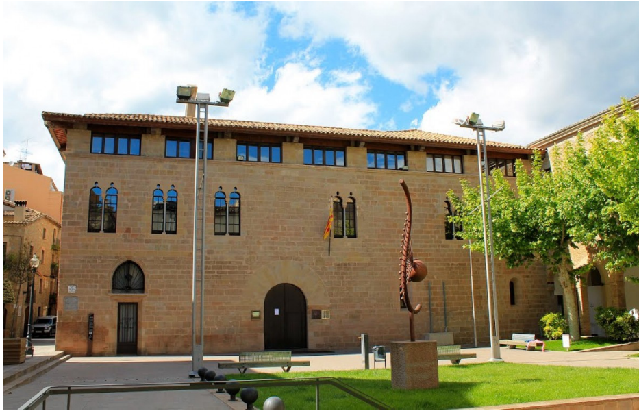
Palau d'en Llobera, edifici gòtic que acull el Consell Comarcal del Solsonès. Foto: Nació Digital
