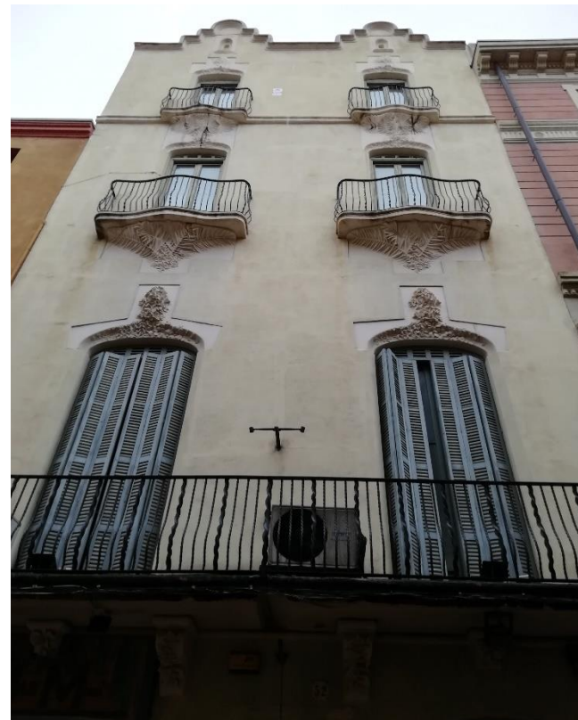
Figura 42 Façana de l'antic Hotel Peninsular. Font: pròpia.
