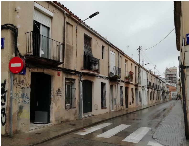
Figura 47 Cases obreres del carrer del Passeig. Font: pròpia.
