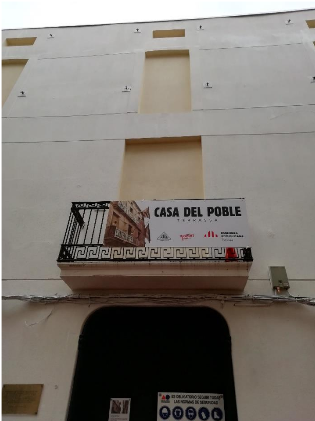
Figura 40 Entrada de l'actual Casa del Poble. Font: pròpia.
