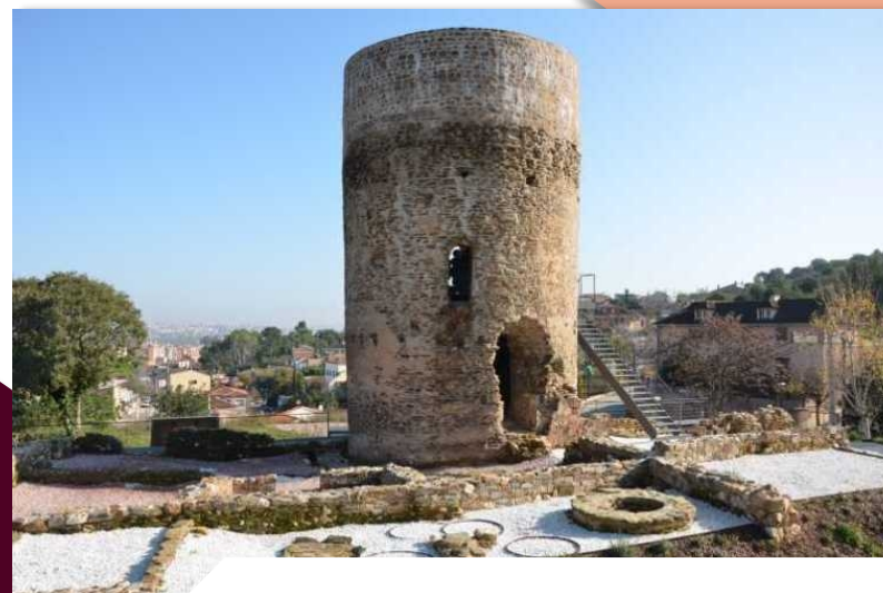
FIGURA.30: Imatge del recinte arqueològic de la Torre de Benviure. Als peus de la Torre s'aprecia l'ús de diferents materials i coloracions per a diferenciar estructures.
