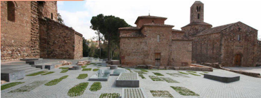
FIGURA 29. Aspecte del recinte del conjunt de la Seu d'Ègara i de l'ús del paviment per a diferenciar estructures. Font: www.patrimoni.gencat.cat
